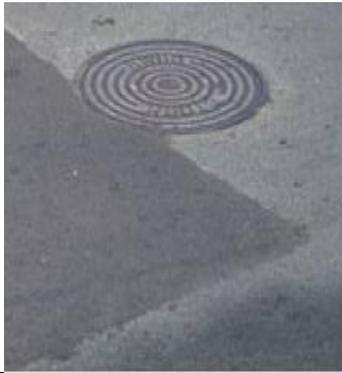
**Remendo:** porção da superfície do pavimento que foi removida e refeita, ou adição de material aplicada sobre o pavimento original. A prática correta de execução é recortar a parte danificada do pavimento, limpar e preencher com material asfáltico semelhante ao original e posterior compactação. O preenchimento de buracos com mistura asfáltica em condições inadequadas prejudica a vida útil do pavimento e sua regularidade.
