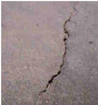
**Trincas Isoladas:** são trincas lineares que se manifestam paralelas ao eixo (trincas longitudinais) ou perpendiculares (trincas transversais). Podem ocorrer por má aderência entre camadas, por reflexão de trincas que afetam a estrutura do pavimento ou por retração térmica.
