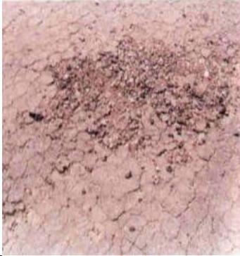
**Desagregação:** corrosão do revestimento do pavimento, caracterizada pelo desalojamento progressivo de partículas do agregado, indicando que o ligante endureceu significativamente. Pode ser causada por tensão de cisalhamento horizontal, conseqüente do tráfego; massa asfáltica muito dura e quebradiça e presença de água que entra no pavimento através dos vazios intercomunicados, sob alta pressão hidrostática motivada pelo tráfego.
