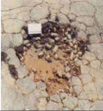
**Buraco:** cavidades de diversos tamanhos que ocorrem no revestimento, resultantes de uma desintegração localizada. Geralmente causados por aplicação insuficiente de asfalto ou por ruptura da base associada a uma drenagem deficiente, evoluem, sob a ação do tráfego e em presença de água. Pode-se evitar a formação de buracos reparando-se antecipadamente defeitos do pavimento, particularmente as trincas por fadiga.
