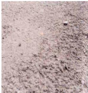
**Desgaste:** consiste na perda de adesividade do ligante asfáltico e desalojamento progressivo das partículas de agregado. No início há perda de agregados miúdos, mas, com a evolução do problema, ocorrem perdas de agregados graúdos e a taxa superficial torna-se cada vez mais áspera.
