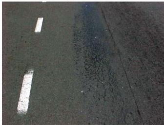
**Exsudação:** Excesso de ligante asfáltico na superfície do pavimento, que diminui o coeficiente de atrito pneu-pavimento. Ocorre mais frequentemente em países de clima quente, tendo como causas o excesso de ligante, o baixo índice de vazios da mistura e a compactação pelo tráfego.
