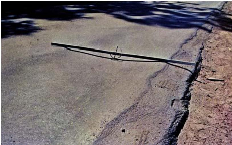
Figura 4 – Afundamento na trilha de roda (Fonte: DAER/RS, 1978).
