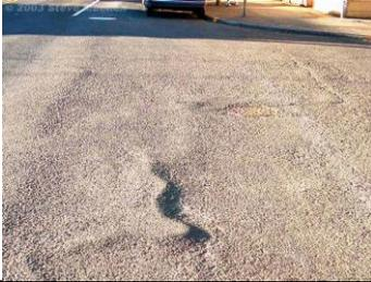
**Corrugação:** formação de ondulações na superfície do pavimento asfáltico. Ocorre em locais que apresentam elevados esforços tangenciais, evidenciando uma mistura instável em virtude de problemas de dosagem ou de problemas construtivos.
