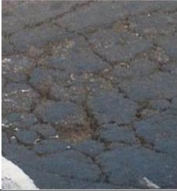
**Trincas por Fadiga:** compreendem as trincas em bloco e as couro de jacaré, que são trincas conectadas, formando uma série de pequenos blocos, de geometria regular ou irregular. A causa das trincas por fadiga (couro de jacaré) está relacionada com as deformações repetidas provocadas pelas cargas de tráfego. As trincas em bloco estão associadas a mudanças no volume de misturas asfálticas e ausência de tráfego como fator que acelera sua evolução.
