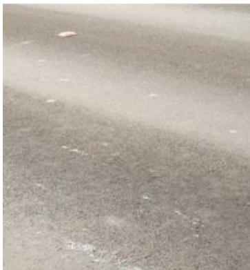
**Afundamento em trilha de roda:** caracteriza uma deformação permanente do pavimento, um tipo de distorção que se manifesta sob a forma de depressões longitudinais, sendo decorrente da densificação dos materiais ou de ruptura por cisalhamento. As distorções resultam, geralmente, da compactação deficiente das camadas do pavimento, excesso de finos na mistura asfáltica, excesso de ligante asfáltico e expansão ou contração das camadas inferiores.
