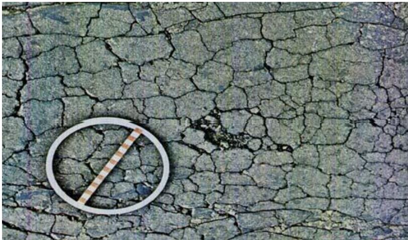
Figura 2 – Trincamento FC-3 (Fonte: DAER/RS, 1978).
