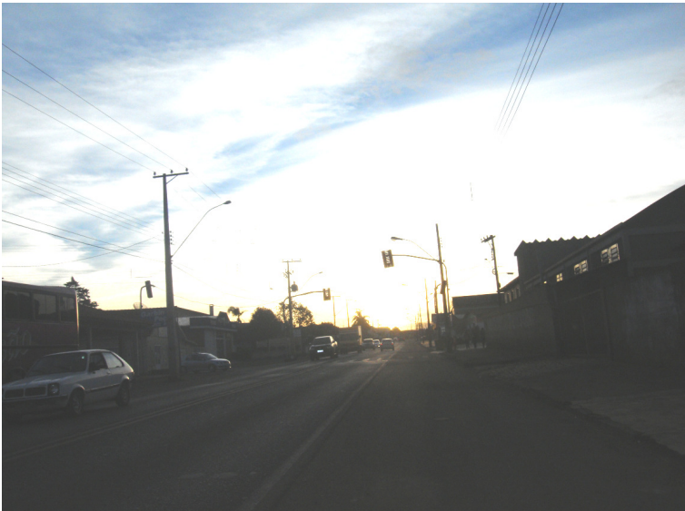
Figura 27. Imagem no sentido crescente da rodovia (km 121+001 ao km 122+000) (d)
