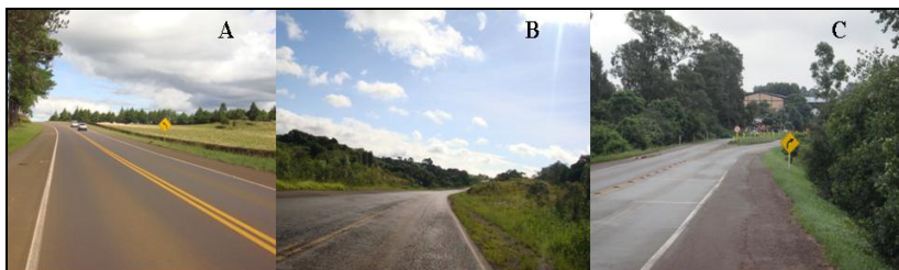
Figura 22. Problemas na Infraestrutura básica da rodovia
