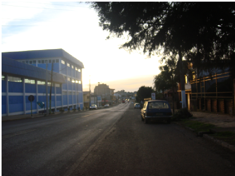
Figura 24. Imagem no sentido crescente da rodovia (km 121+001 ao km 122+000) (a)
