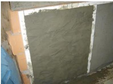
Figura 172 – Revestimento da argamassa 1 : 1 : 6 após lançamento aguardando o sarrafeamento
