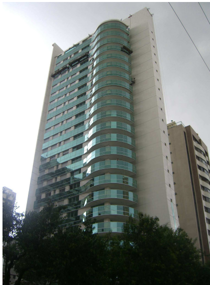
Figura 20 – Fachada ventilada com placas de porcelanato. Fonte: Do autor.
