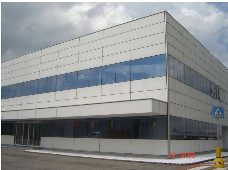
Figura 50 – Fachada ventilada finalizada com porcelanato de fina espessura 3000x1000mm.
