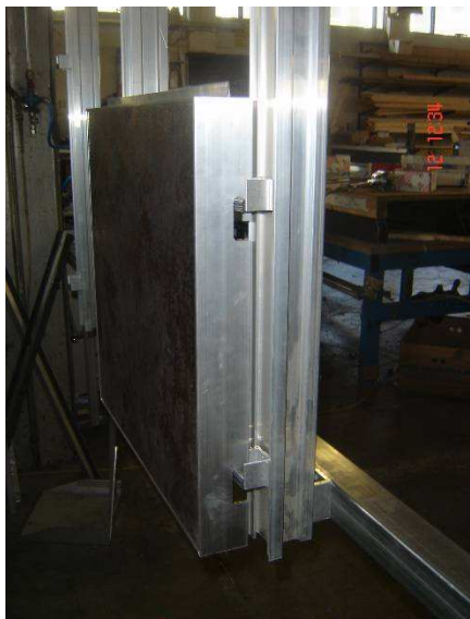
Figura 36 – Detalhe instalação da fachada. Fonte: Do autor.
