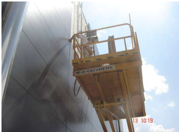
Figura 51 – Instalação de uma fachada ventilada. Fonte: Do autor.
