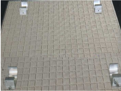
Figura 10 – “Inserts” metálicos inseridos no verso de placas de porcelanato.
