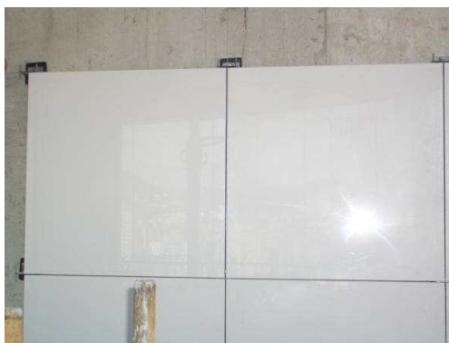
Figura 6 – Placas de porcelanato fixadas em elementos de concreto. Fonte: Do autor.
