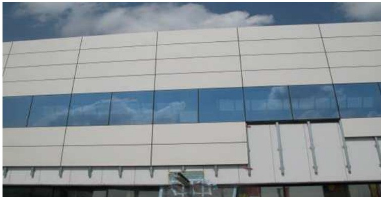
Figura 49 – Instalação fachada ventilada com porcelanato de fina espessura 3000x1000mm.
