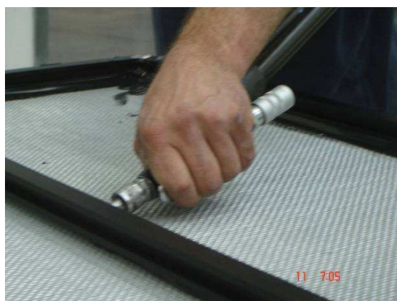
Figura 29 – Aplicação adesivo estrutural.
