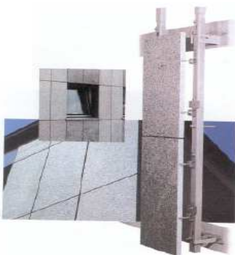
Figura 7 – Placas pétreas fixadas com o auxílio de uma subestrutura auxiliar.
