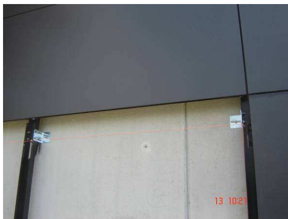
Figura 33 – Detalhe perfis e ancoragens.
