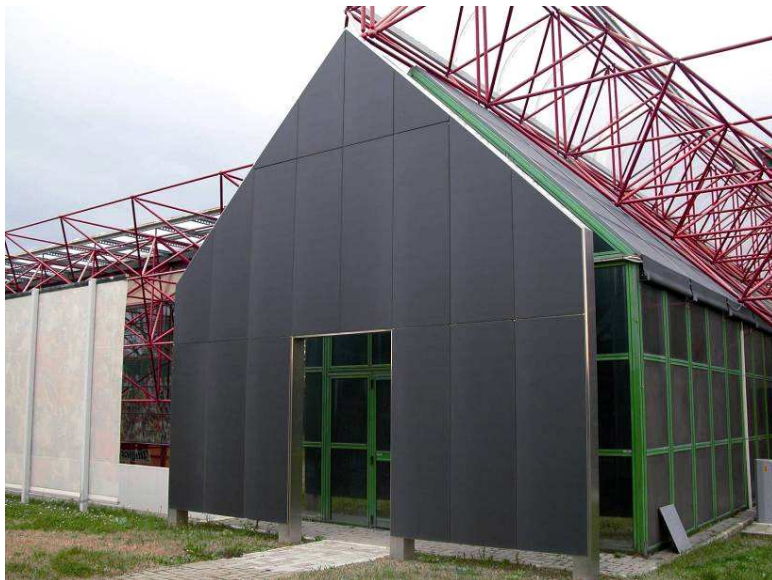
Figura 53 – Instalação fachada ventilada com porcelanato de fina espessura 3000x1000mm.
