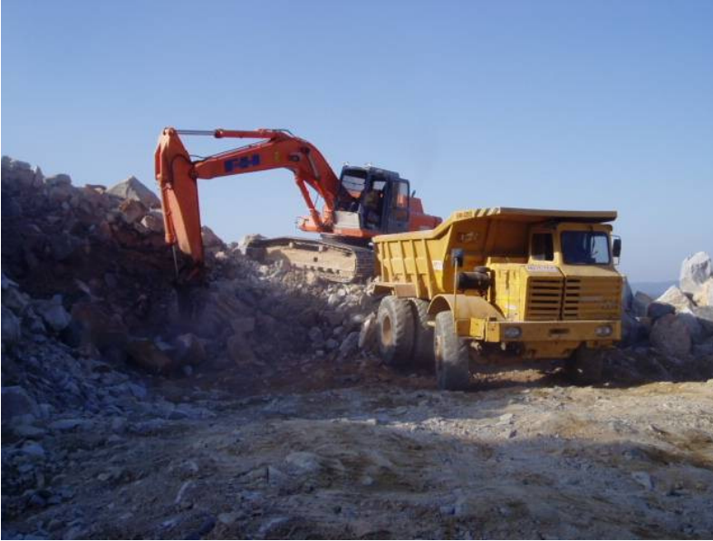
Figura 79 – Carregamento do material detonado.
