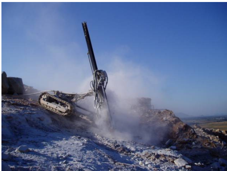
Figura 78 – Furação do maciço rochoso para posicionar o explosivo.
