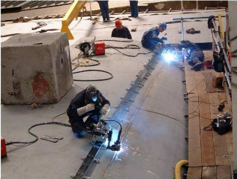
Figura 6 - Aplicação de manipuladores de soldagem [4]
