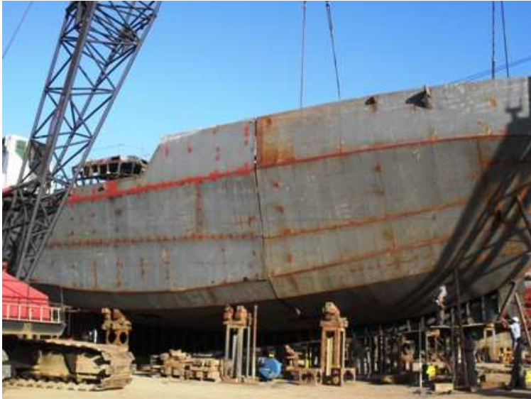
Figura 5-Edificação de uma embarcação
