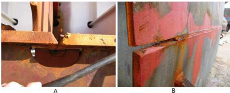
Figura 14 - Soldagem de costado. Em A o detalhe da junta e em B os cordões de solda.
