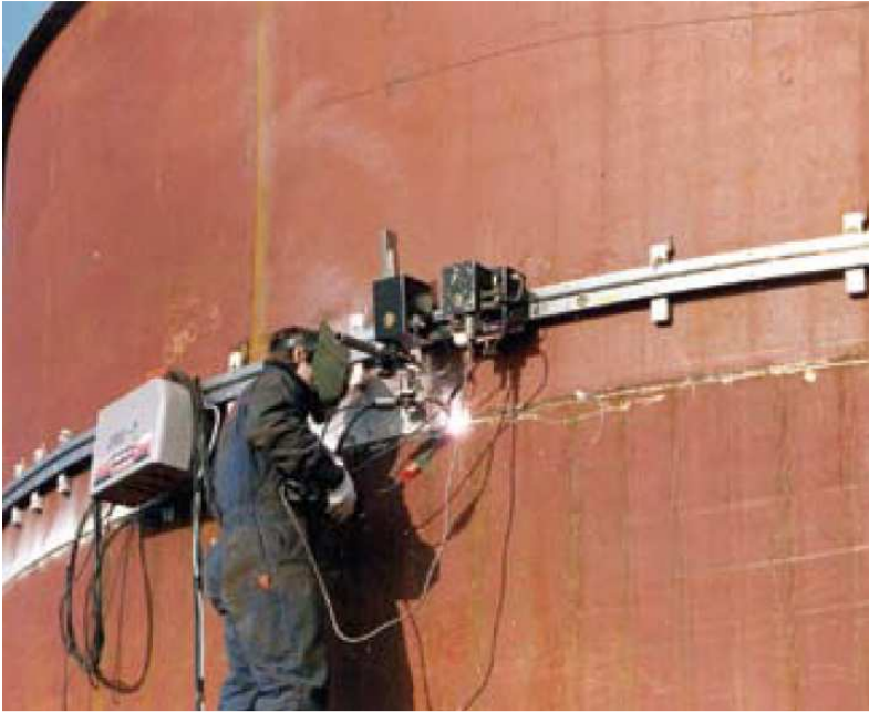
Figura 15 - Soldagem automatizada de costado [18]
