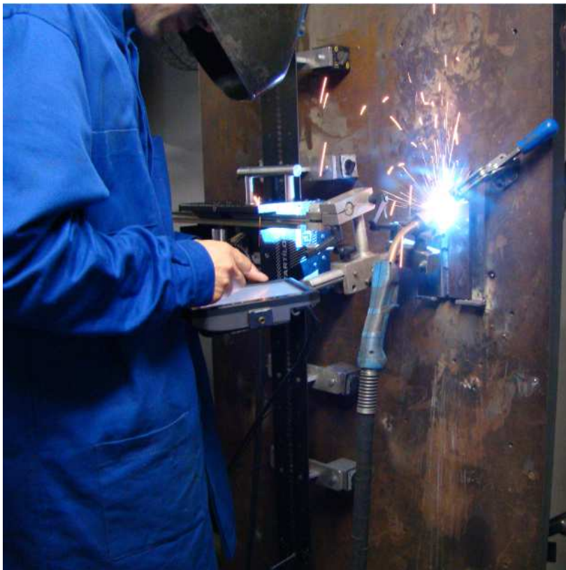
Figura 59 - Soldagem da junta da figura 58 com o Tartílope V2F
