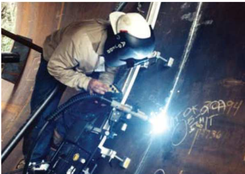
Figura 16 - Soldagem mecanizada com correção manual [18]
