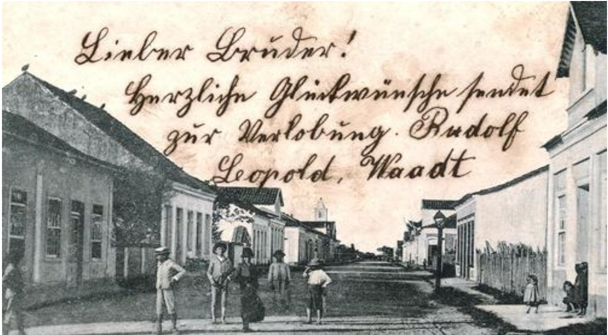
Rua Hercílio Luz, ano de 1906. Ao fundo (à esquerda) é possível perceber a parte superior da torre da Matriz. Fonte A.P.I.
