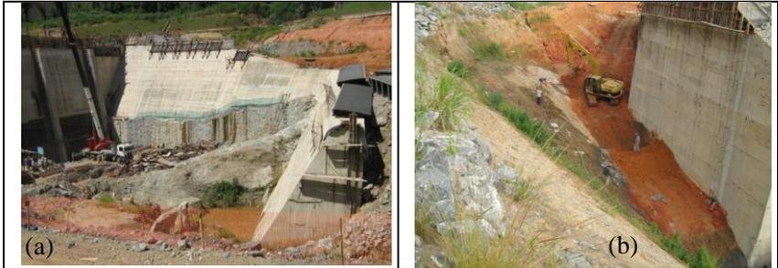
Figura 6: PCH Monte Serrat - Muro de aproximação da ombreira direita, sendo (a) Vista da face do canal de aproximação, (b) Vista da face do muro da ombreira direita durante a compactação do aterro entre o muro de aproximação e a encosta natural (fotos cedidas por Engevix Engenharia).
