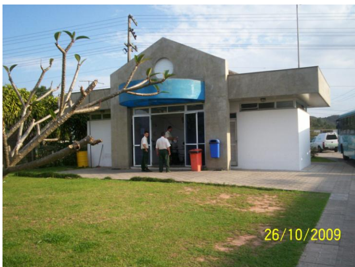
FIGURA 8 – Sala dos motoristas e cobradores TICAN
