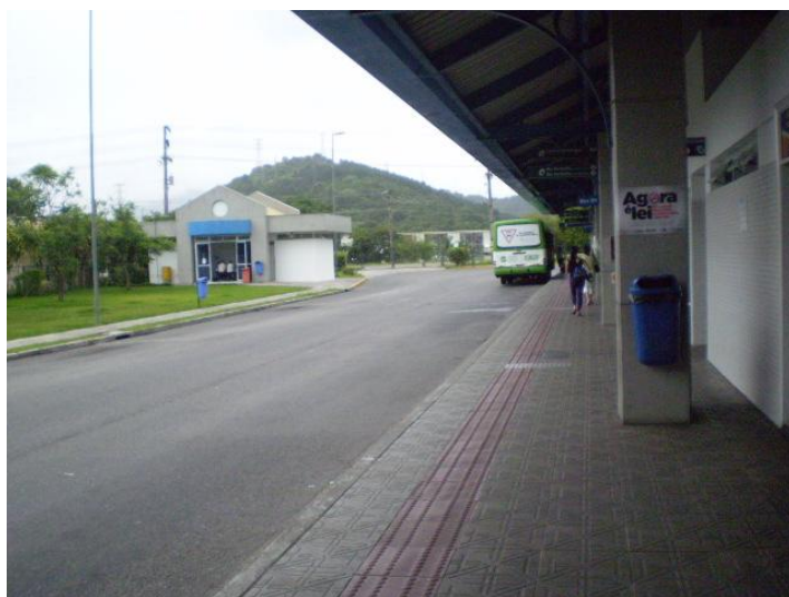
FIGURA 9 – Pista de rolamento e sala dos motoristas e cobradores TICAN
