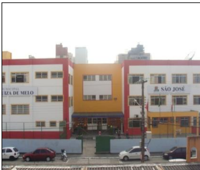
Figura 2: Fachada do Colégio – Prédio 1
