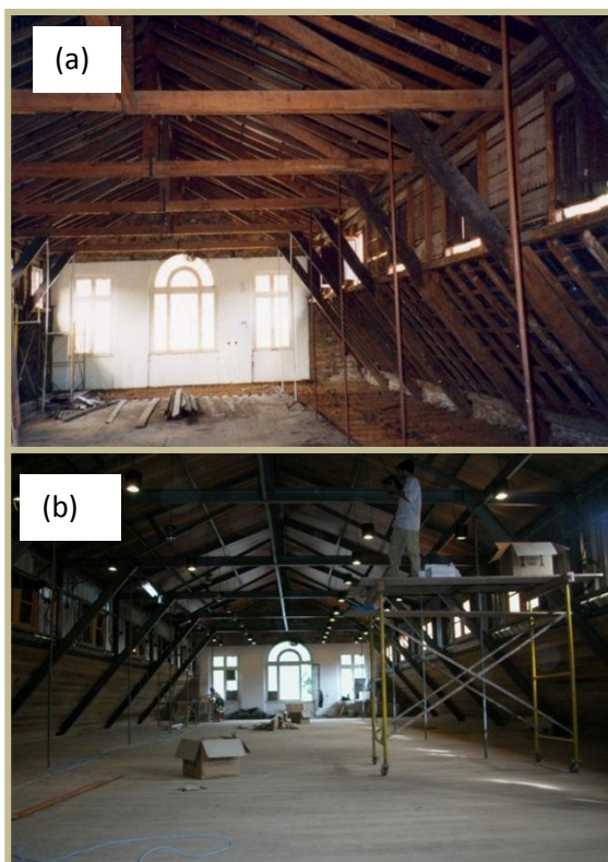
Figuras 81 (a) e (b)–Fotografia da tesoura utilizada na ala central 03 antes e depois do restauro iniciado em 2004. Fonte: acervo Secretaria do Patrimônio Histórico / Divisão de pesquisa Histórica e Documental da UFRGS
