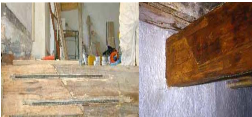
Figuras 59(a) e (b) – Prótese com nova peça de madeira, resina epóxi e lâmina de madeira: Fonte: Pizzo,B.;Lavisci,P. (2008) Curso construción em madeira.
