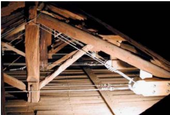
Figura 56 - Reforço com utilização de tirantes. Fonte: Pizzo,B.;Lavisci,P. (2008) Curso construción em madeira.
