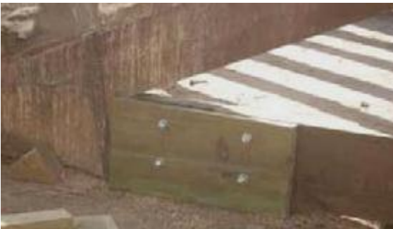
Figura 51 – Aumento de seção com talas laterais. Fonte: Pizzo,B.;Lavisci,P. (2008) Curso construcción em madeira.
