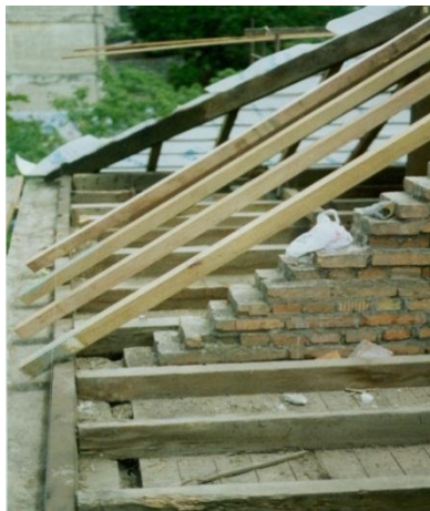
Figura 43 – Exemplo de substituição total em madeira na cobertura do prédio Curtumes e tanantes, UFRGS. Fonte: acervo Secretaria do Patrimônio Histórico Divisão de pesquisa Histórica e Documental da UFRGS, 2003.
