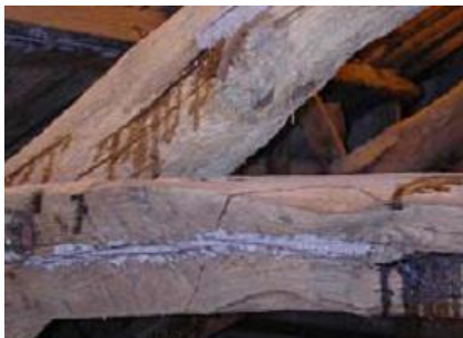
Figura 57 - Selagem de fendas com preenchimento de resina epóxi. Fonte: Lopes, 2007
