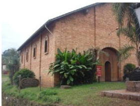
Figura 58. Novo prédio onde estão os tonéis de aço inox.
