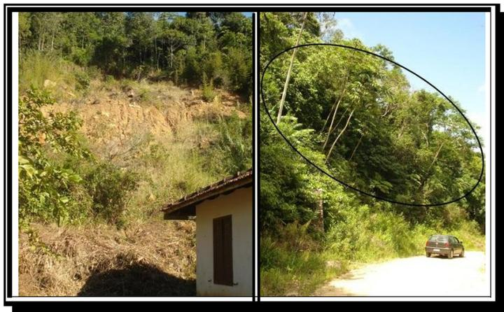
Figura 20: Área de corte da encosta no fundo do lote onde já houve movimentos de massa (foto a esquerda) e, indícios de rastejamento com árvores inclinadas (foto a direita).
