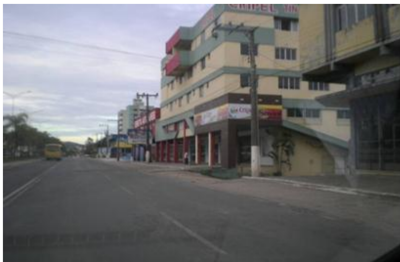
Figura 69. Edificações em 2010, construídas a partir do Plano Massa.
