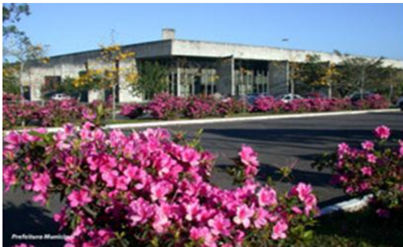
Figura 51- Vista da Prefeitura Municipal de Criciúma em 2009.
