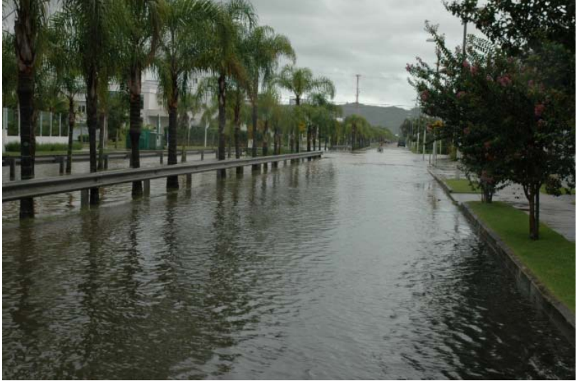
Figura 73: Avenida Dourados em janeiro de 2011. Transbordamento do canal de drenagem. Fonte / Foto: Enio Noronha Raffin.
