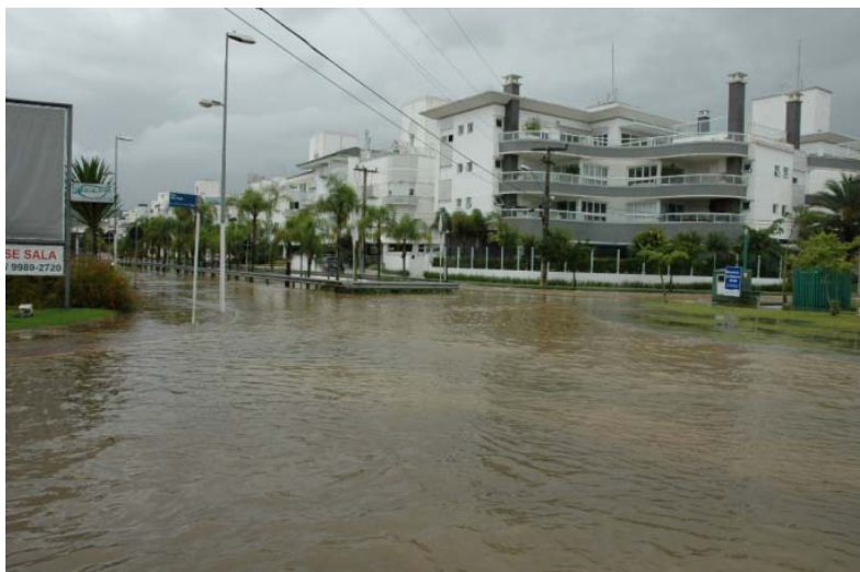
Figuras 76: Esquina entre as avenidas Dourados e Algas, em janeiro de 2011. Transbordamento dos canais de drenagem. Fonte / Foto: Enio Noronha Raffin.
