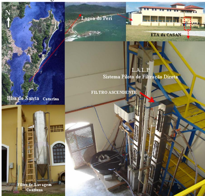
Figura 3.1 – Local de implantação do sistema piloto de filtração direta com filtro de lavagem contínua.
