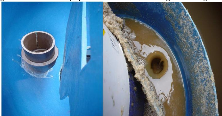
Figura 3.11 – Fotos da peça de controle de nível de água de lavagem.
