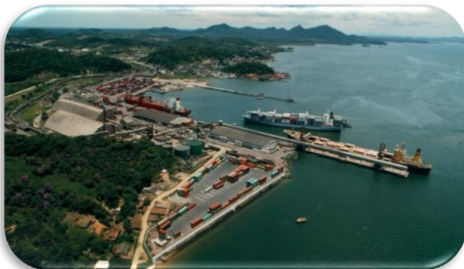
Figura 1.3. Foto aérea no Porto de São Francisco do Sul (Disponível em: http://www.vacaria.net/img/porto_saofrancisco.jpg . Acesso em: 09 fev. 2010).
