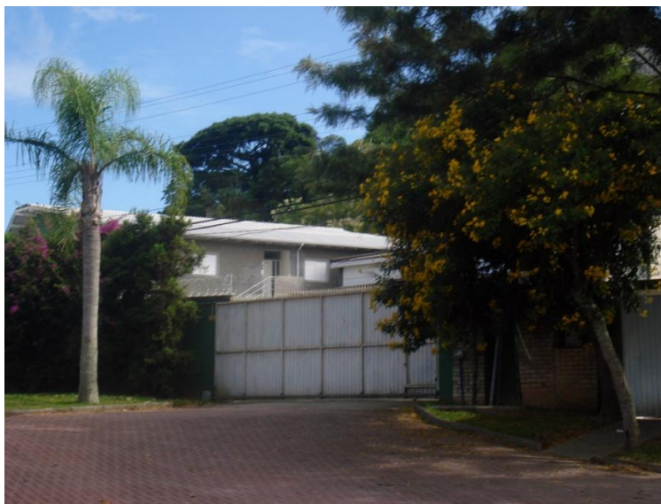
Figura 36 – Barreira física aos fundos do terreno que impede a circulação e a permeabilidade no entorno. Fonte: Acervo pessoal da autora (2010).
