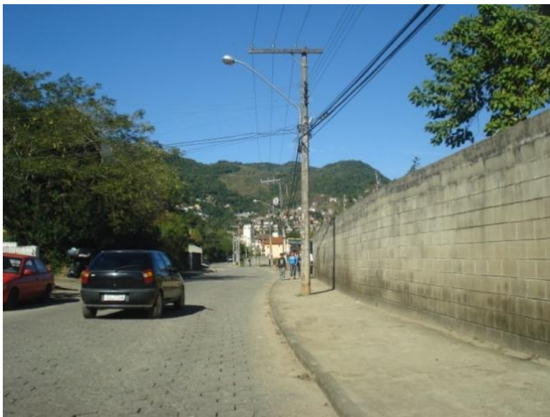
Figura 38 – Parte posterior do terreno onde a barreira física impede o acesso e limita o passeio.
