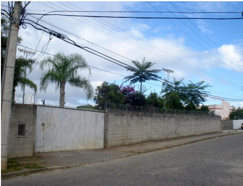
Figura 47 – Rodovia Virgílio Várzea – Barreira física na extremidade do terreno.
