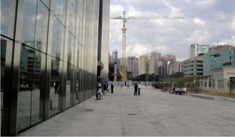
Figura 11 – Recuo posterior. Acesso ao edifício sem espaços de convivências. Fonte: Gustavo Ukita (2010).
