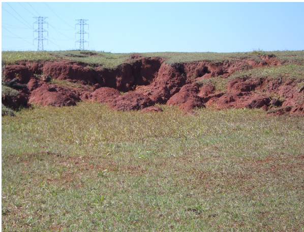
Figura 58 - Feições erosivas próximo à Torres de Transmissão – LT Jupιά-Mimoso.
