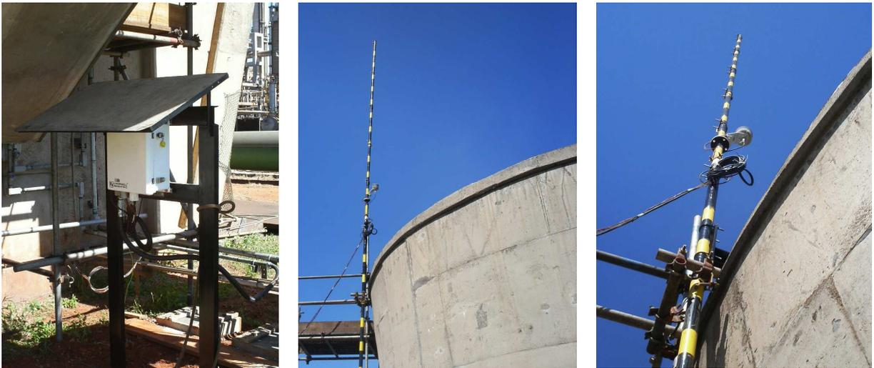
Figura 63 – Fotografias da instalação na Replan: equipamento de aquisição de dados (esquerda) e haste com os sensores no topo da torre (centro e direita).
