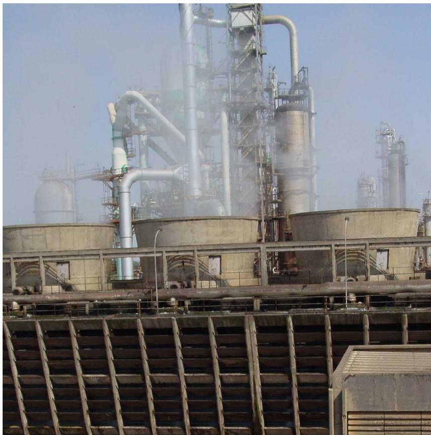
Figura 2 – Fotografia da saída da torre de resfriamento da Replan
