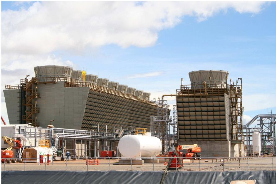
Figura 17 – Fotografia da torre de resfriamento por indução mecânica.
