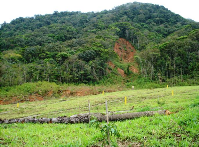
Figura 81 -Detalhe do escorregamento 24. Foto: Fernanda Bauzys (2010).
