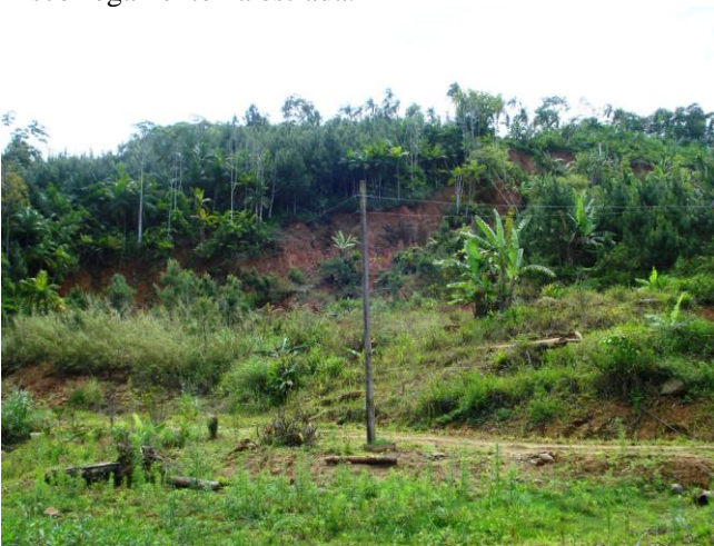
Figura 115- Escorregamento R. Foto: Fernanda Bauzys (2010).
