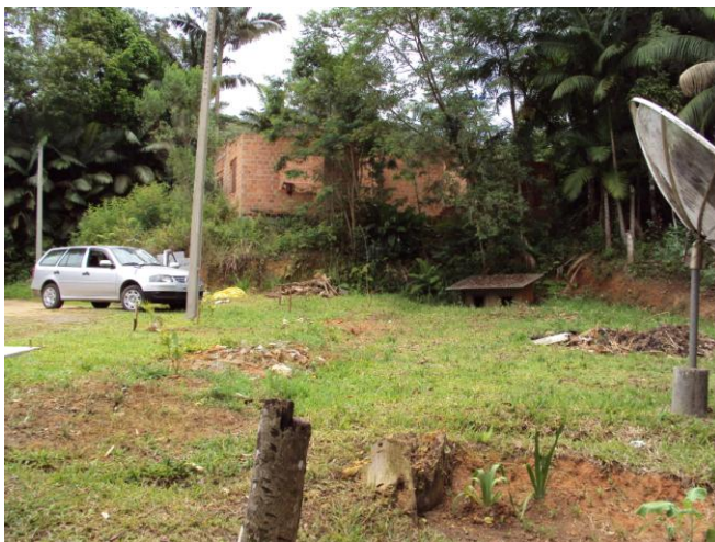
Figura 116- Degrau de abatimento e casa abandonada. Foto: Fernanda Bauzys (2010).
