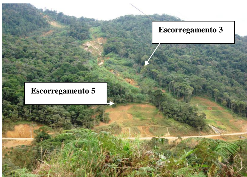
Figura 52- Escorregamento 5. Foto: Fernanda Bauzys (2010).
