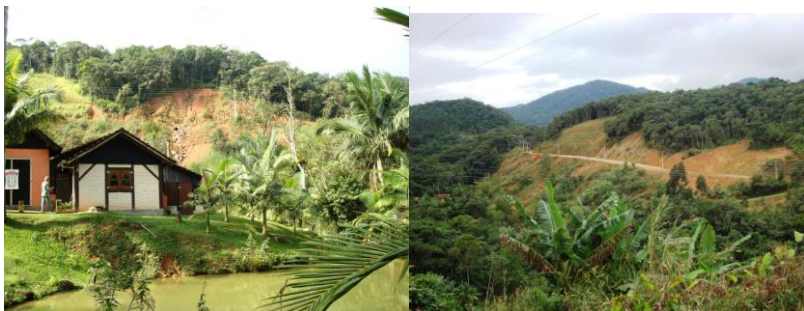
Figura 51- Escorregamento 4. Foto: Fernanda Bauzys (2010).
