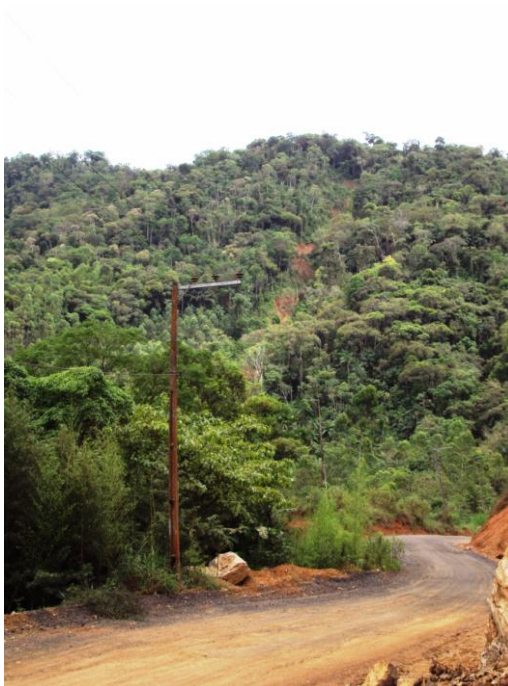
Figura 73 -Escorregamento 18. Foto: Fernanda Bauzys (2010).
