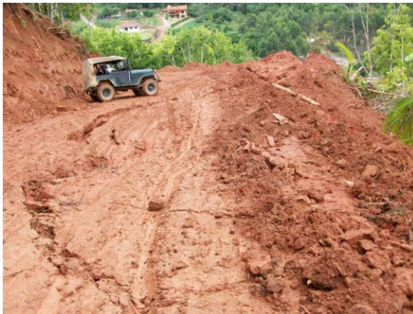
Figura 60- Degrau de abatimento na rua Emilio Roweder, na área 10. Foto: Juan Flores (2009).
