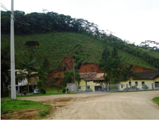
Figura 102- Escorregamento E. Foto: Fernanda Bauzys (2010).
