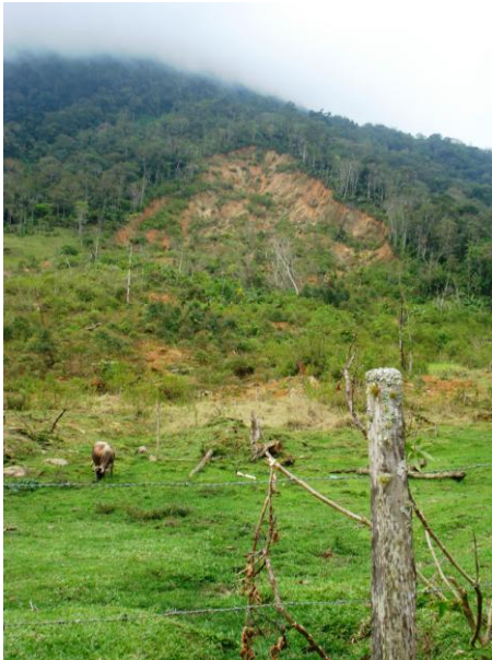
Figura 69- Escorregamento 14. Foto: Fernanda Bauzys (2010).
