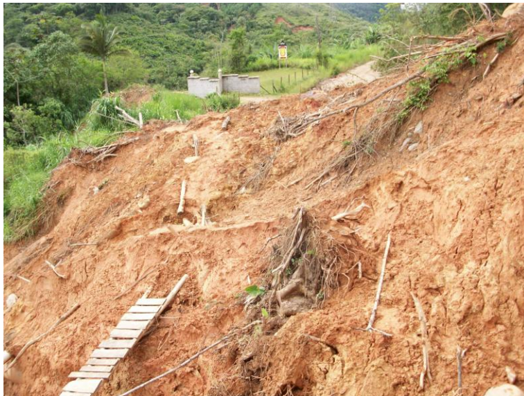
Figura 42 -Escorregamento 1, no ponto em que interditou a estrada de Blumenau-Luis Alves. Foto: Fernanda Bauzys (2009).
