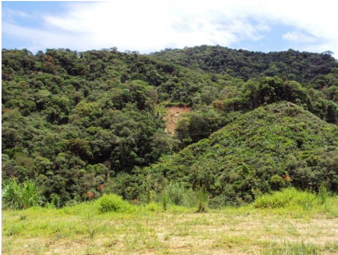
Figura 57- Ruptura do escorregamento 9. Foto: Fernanda Bauzys (2010).
