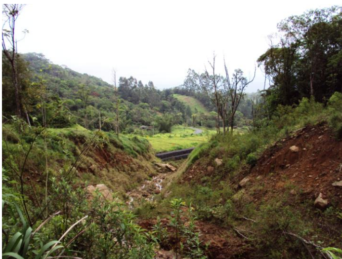
Figura 79- Drenagem onde se encaixaram estes escorregamentos. Foto: Fernanda Bauzys (2010).
