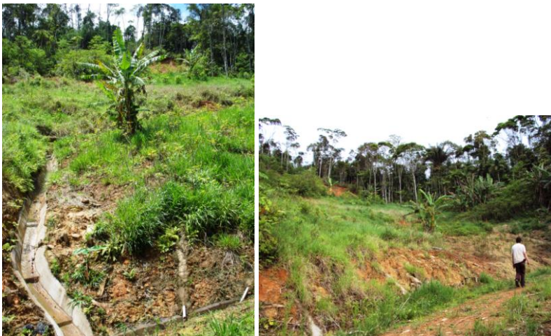
Figura 112- Escorregamento O. Foto: Fernanda Bauzys (2010).
