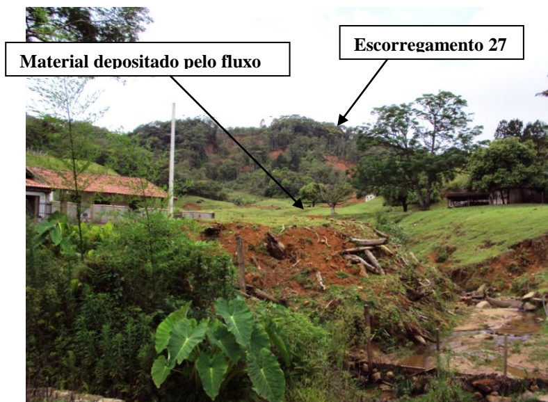
Figura 86 -Escorregamento 27. Foto: Fernanda Bauzys (2010).
