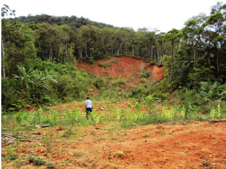
Figura 94 -Detalhe do escorregamento 34. Foto: Fernanda Bauzys (2010).
