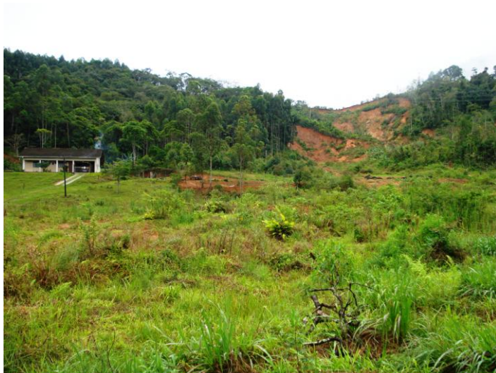
Figura 75 -Escorregamento 19. Foto: Fernanda Bauzys (2010).
