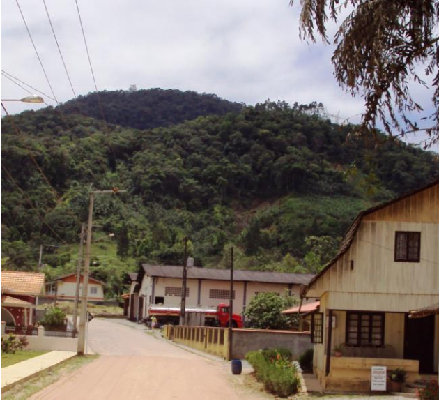
Figura 95 -Escorregamento 35. Foto: Fernanda Bauzys (2010).
