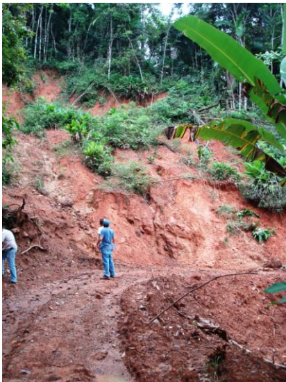
Figura 53- Escorregamento 6. Foto: Fernanda Bauzys (2010).
