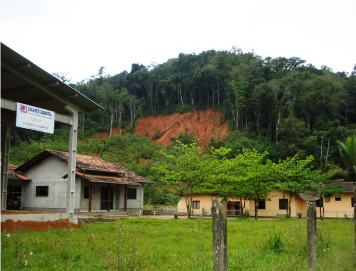
Figura 92 -Escorregamento 33. Foto: Fernanda Bauzys (2010).
