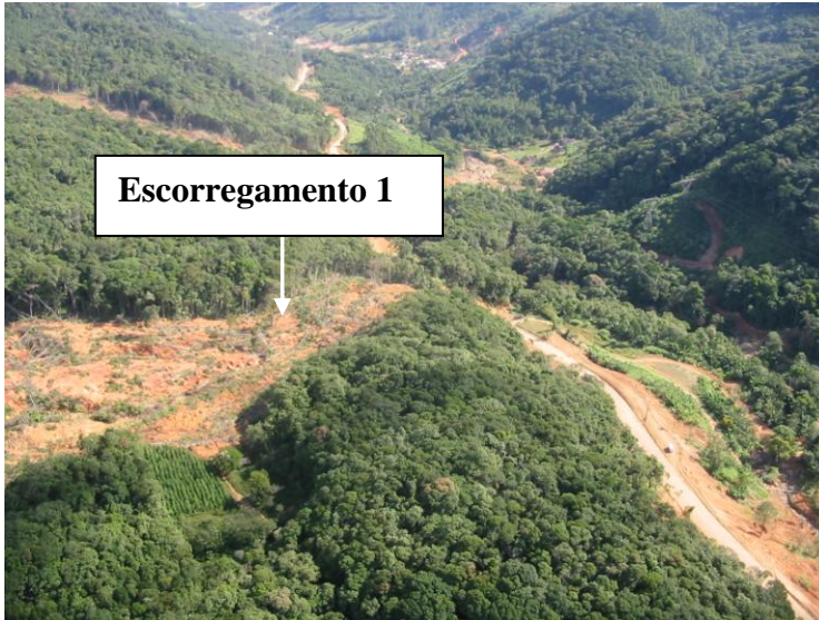
Figura 37- Vista de helicóptero do escorregamento 1. Foto: Joel Pellerin (2009).
