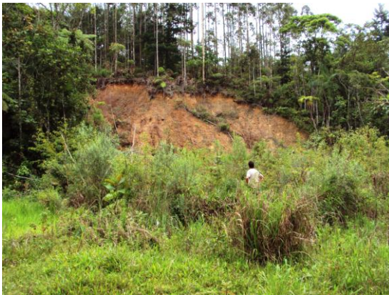
Figura 118- Escorregamento T. Foto: Fernanda Bauzys (2010).
