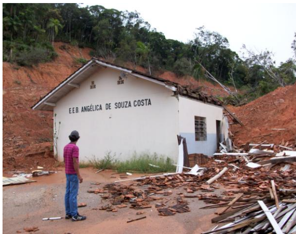
Figura 32 -Escola destruída no bairro de Sertão Verde, em Gaspar. Foto: Fernanda Bauzys (2009).
