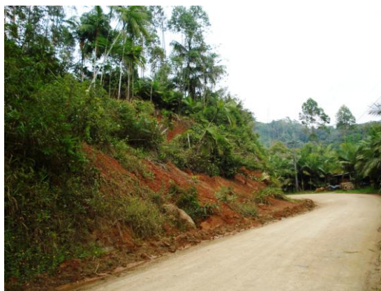
Figura 105- Escorregamento H. Foto: Fernanda Bauzys (2010).
