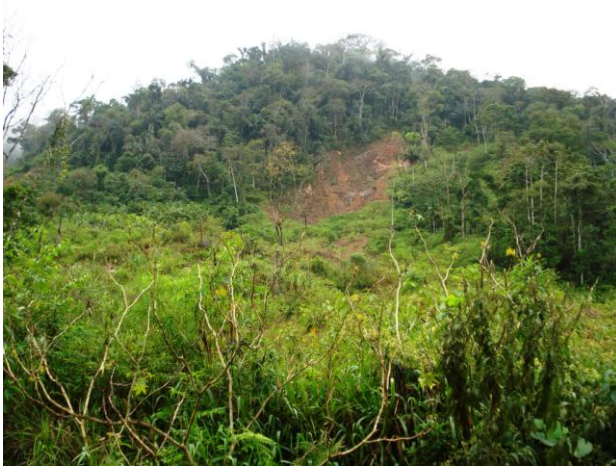
Figura 71- Escorregamento 17. Foto: Fernanda Bauzys (2010).
