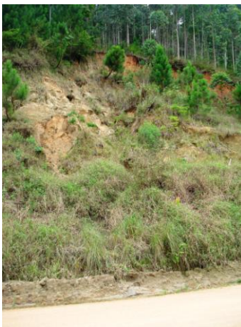
Figura 101- Escorregamento D. Foto: Fernanda Bauzys (2010).
