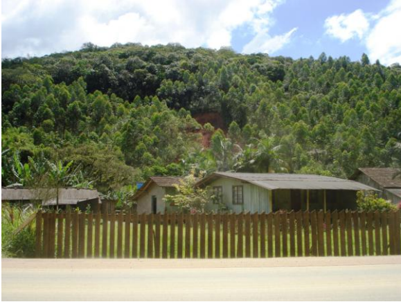
Figura 114- Escorregamento Q. Foto: Fernanda Bauzys (2010).
