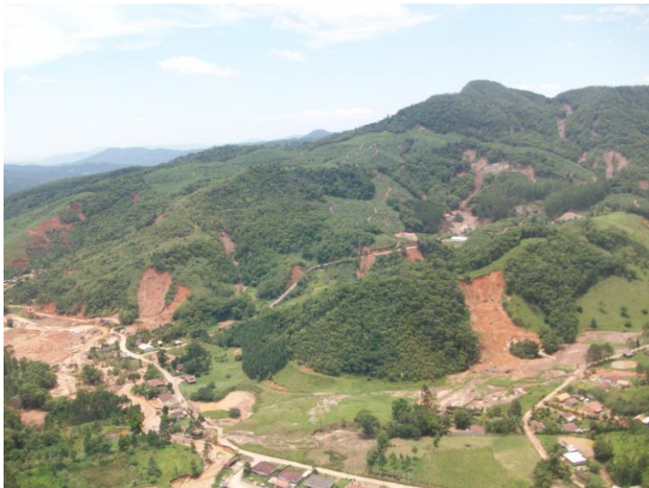
Figura 21 -Escorregamentos generalizados no Alto Baú, em Ilhota-SC. Foto: Fernanda Bauzys (2009).
