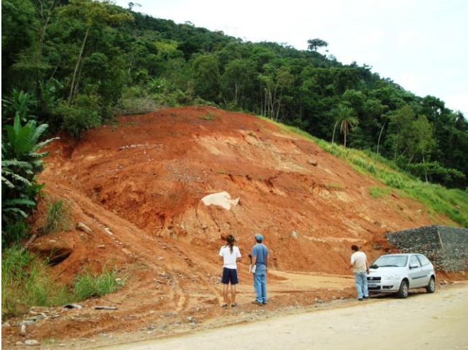
Figura 54 -Escorregamento 7. Foto: Fernanda Bauzys (2010).
