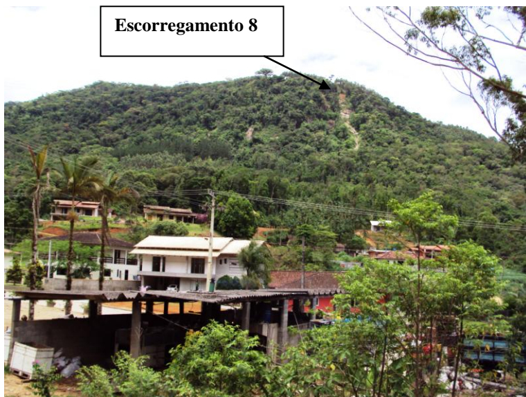
Figura 55- Escorregamento 8. Foto: Fernanda Bauzys (2010).
