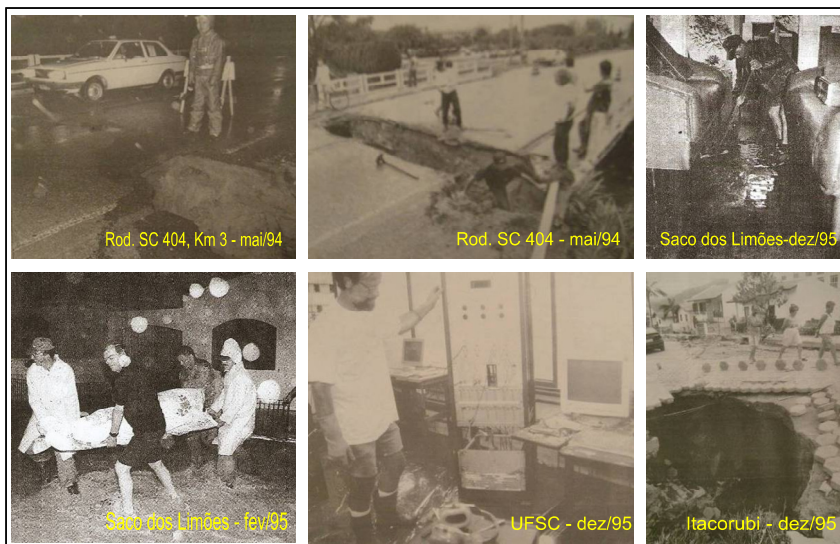
Figura 4.8 - Desmoronamento de uma parte da pista do quilometro 3 da SC-404, pista da SC-404 cedeu e rodovia foi interditada, morador do bairro Saco dos Limões sendo retirado de sua residência que foi alagada, morador retira muito barro de sua residência no bairro Saco dos Limões (rua Almeida Coelho), Rua Luis Pasteur no Itacorubi e Laboratórios das engenharias inundados em dezembro de 1995.
