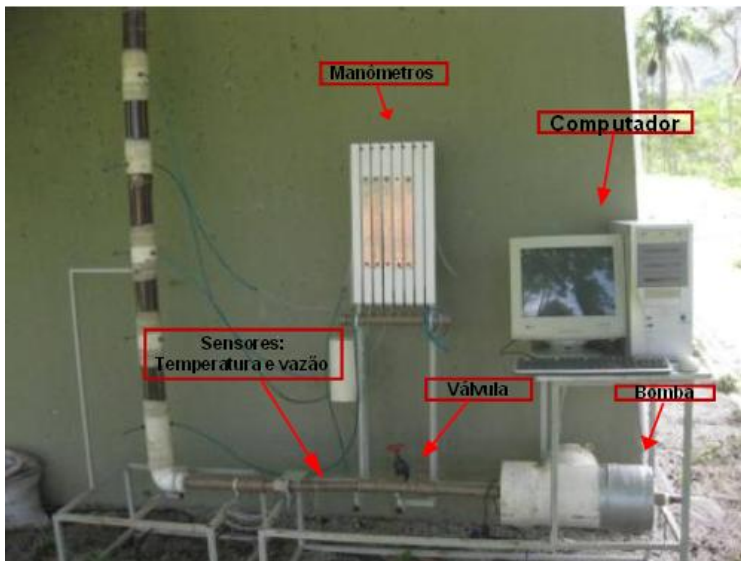
Figura 11: Piloto para realizar os testes de remoção de H 2 S.
