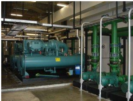
Figura 11 – Entrada da água proveniente das torres de arrefecimento, 2007
