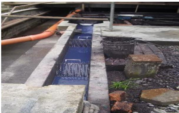
**Figura 20:** Grade inclinada de limpeza manual da estação de tratamento da Estamparia Cores e Tons.
