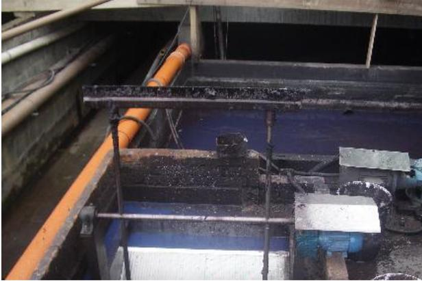
**Figura 21:** Peneira automática da estação de tratamento da Estamparia Cores e Tons.
