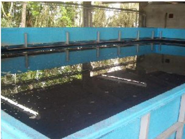
**Figura 22:** Tanque sedimentador da estação de tratamento da Estamparia Cores e Tons.
