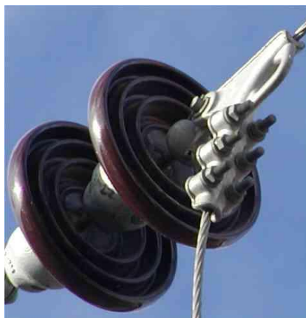
Figura 5. Fotografia ilustrando isoladores tipo suspensão montado na linha. [29]
