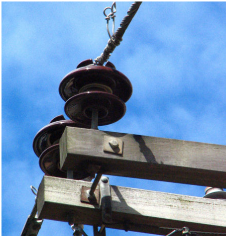
Figura 4.13 – Isoladores Tipo Dois-corpos Porcelana
