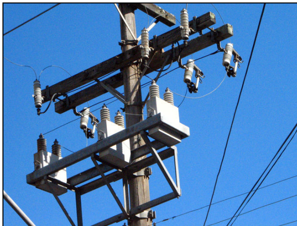
Figura 4.22 – Instalação de Capacitores de Potência
