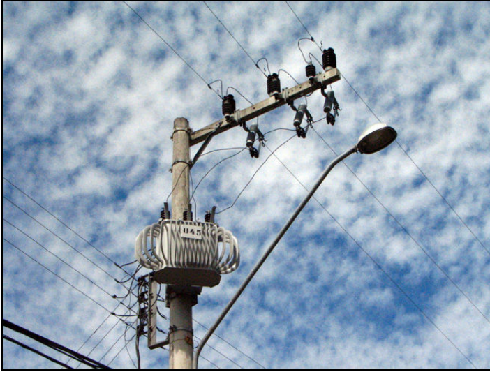
Figura 4.15 – Instalação de Transformador de Distribuição Trifásico
