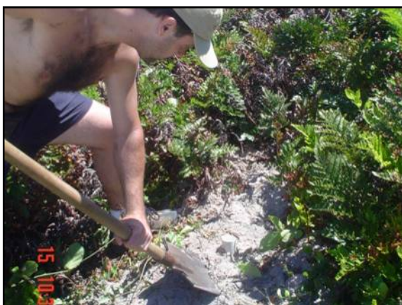
Foto 5 – Marco topográfico instalado na base do perfil praial 2. Foto de Ulisses Rocha de Oliveira (15/12/2007).
