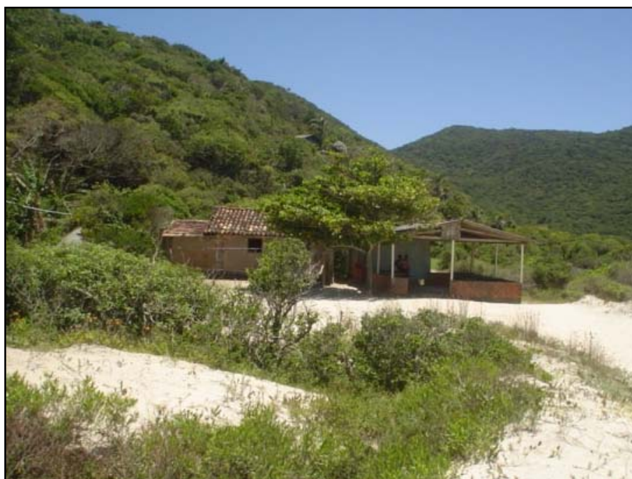
Foto 21 – Vista geral das edificações dispostas sobre as dunas próximas ao perfil 3.
