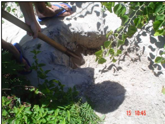
Foto 3 – Abertura de cava para instalação do marco topográfico de referência do perfil praial 2. Foto de Alexandre Felix (15/12/2007).
