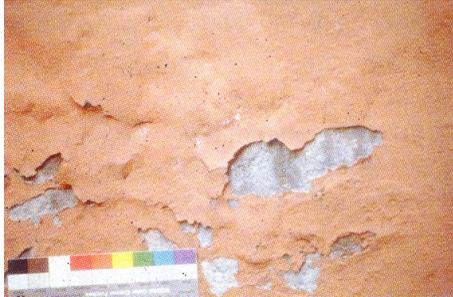
**Figura 14** - Degradação típica da tinta sintética. Fonte: Ceregato, 2000.
