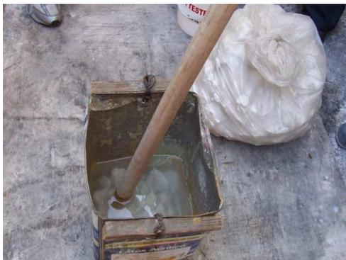
**Figura 9** - Hidratação manual da cal em canteiro.
