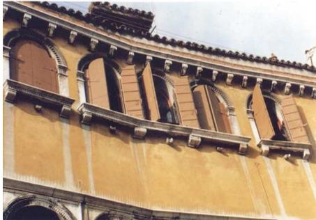
**Figura 15** - Degradação típica da pintura a cal. Fonte: Ceregato, 2000.
