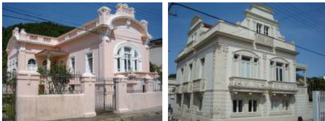
Figura 26: Edificações com influencia do movimento eclético. Fonte: acervo próprio, 2008.
