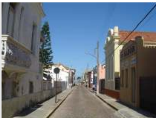
8. Vista geral Rua Barão do Rio
