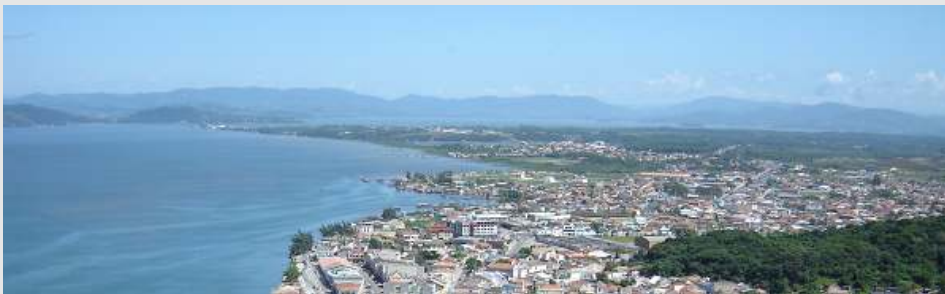
Vista geral da Unidade de Paisagem V a partir do leste Fonte: IPHAN-SC, 2010.
