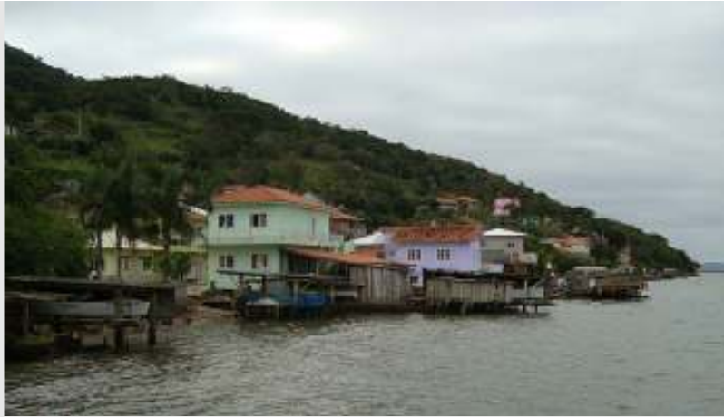
8. Edificações construídas em áreas de APP com elevado risco de desmoronamento. Implantadas no sopé de encostas com declividades superior a 30% e as margens da lagoa de Santo Antonio.
