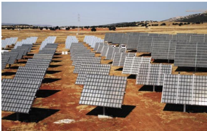
Figura 2.31 - Campo de testes do ISFOC em Puertollano, com 800 kW N de SFVC instalados, sendo: 200 kW N da Concentrix (frente), 200 kW N da SolFocus (atrás à esquerda) e 400 kW N da Isofotón (direita).
