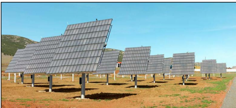
Figura 2.28 – Planta fotovoltaica de 100 kW N , com SFVC Concentrix, instalada em Puertollano, Espanha.
