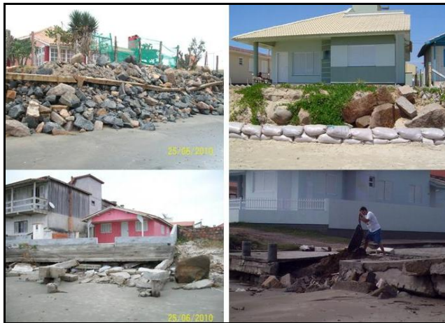
Figura 36. Tentativas de conter a erosão no setor norte da praia de Itapirubá (Fotos de Ana Fátima da Silva, 2008, 2009 e 2010).
