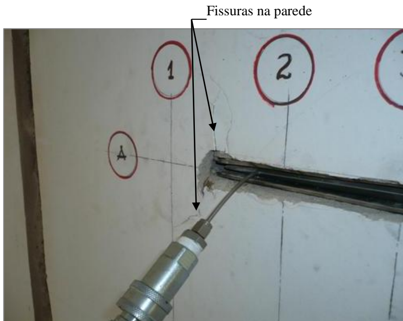
Figura 72 – Surgimento de fissuras no ensaio C
