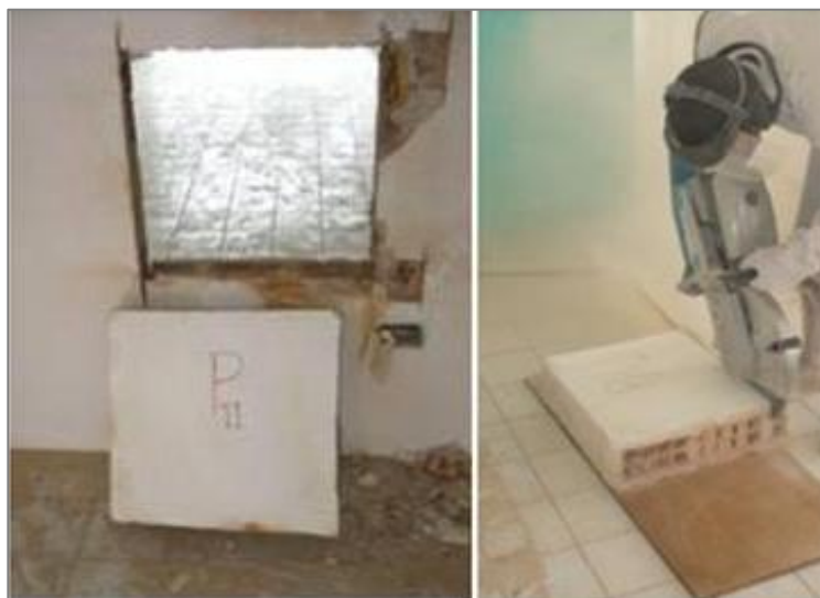
Figura 89 – Imagem da retirada do P11 e o aparelhamento das bordas
