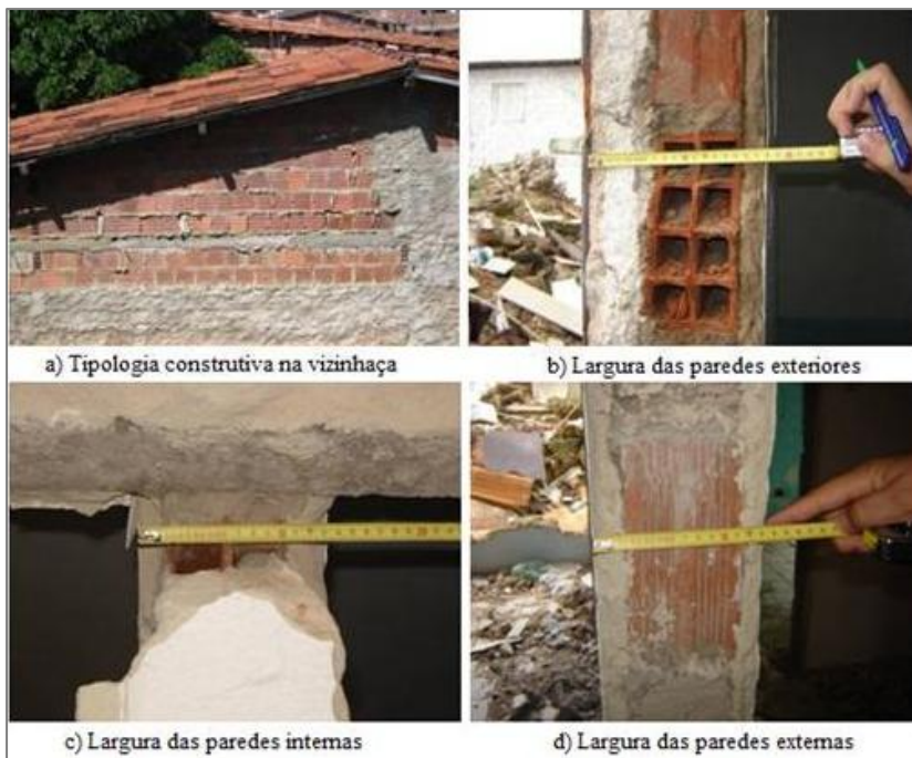
Figura 40– Inspeção das paredes acima do Piso0
