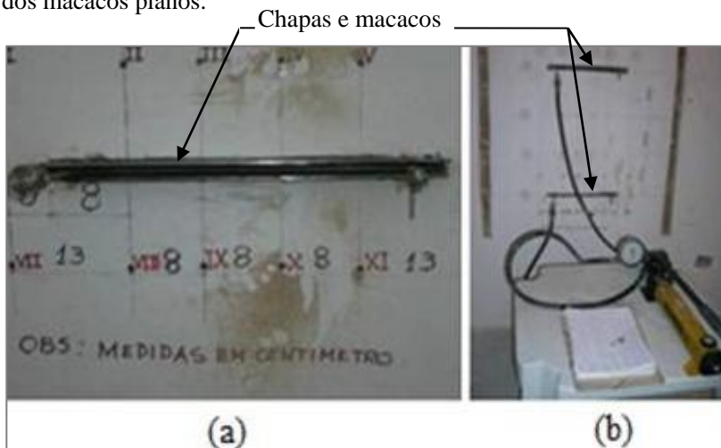
Figura 67 – Preparação do ensaio C com macacos planos: (a) ajuste do macaco por intermédio de chapas de interposição; e (b) detalhe do sistema hidráulico ligado aos dois macacos
