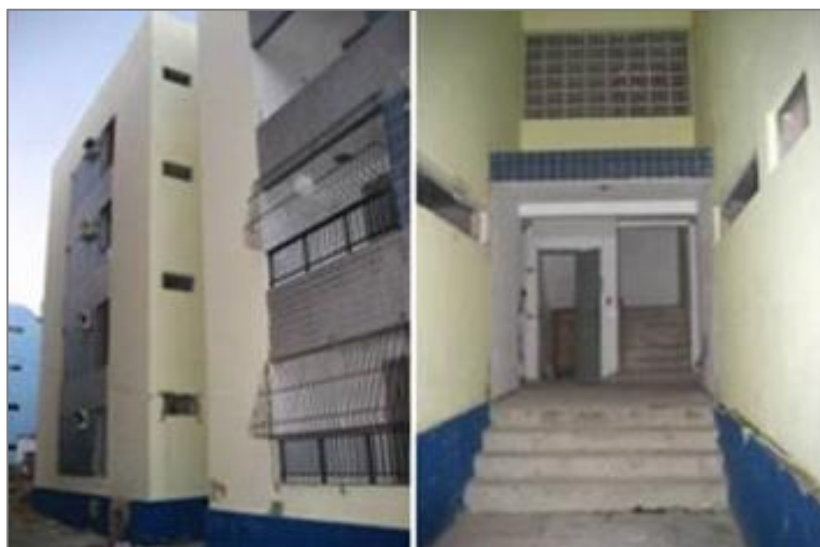
Figura 34– Vista da lateral do edifício e acesso aos pavimentos
