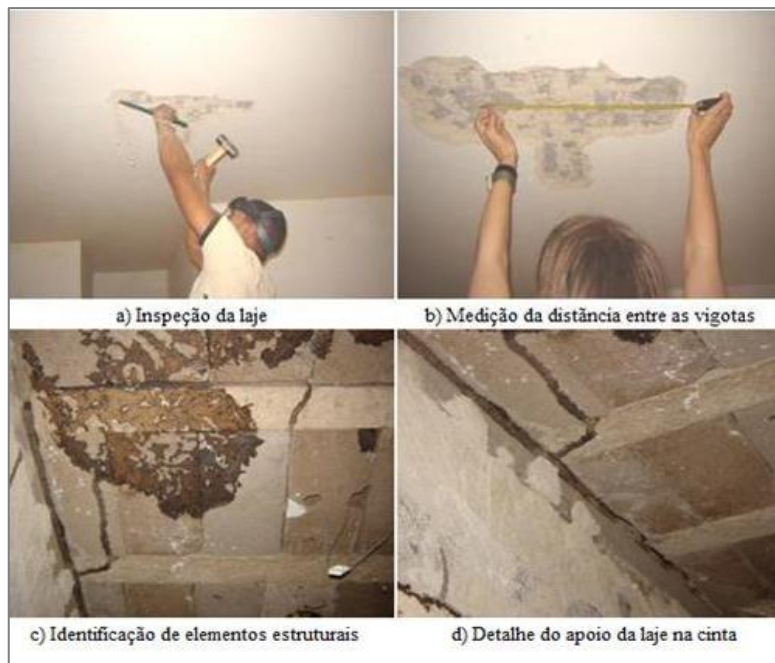
Figura 41– Inspeção da laje de piso
