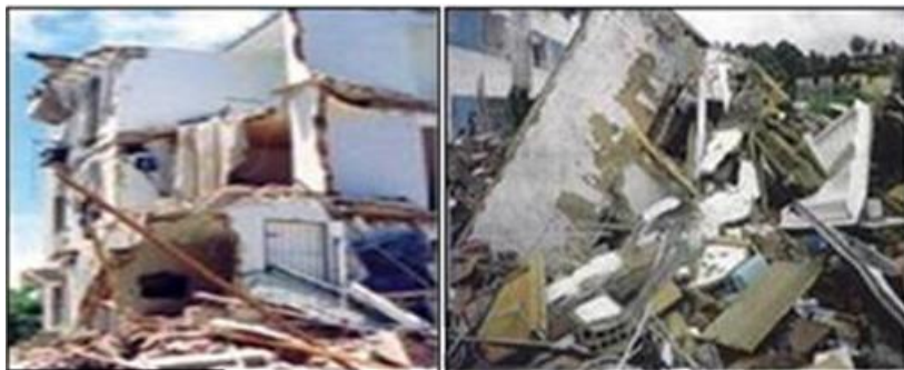
(a) Edifício Éricka
