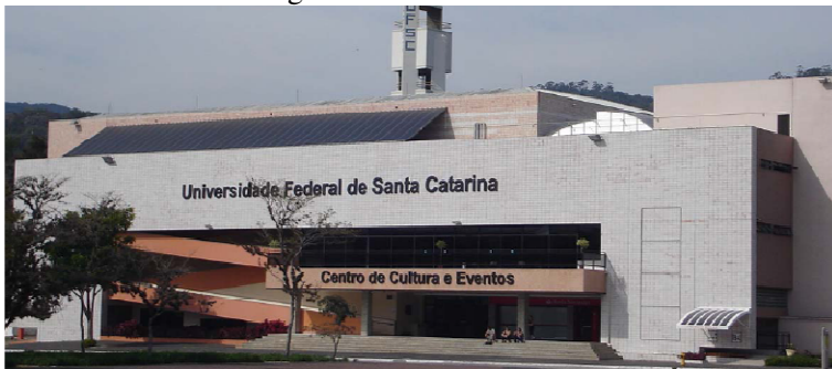
Figura 30. Sistema fotovoltaico de 10,24 kWp integrado ao Centro de Cultura e Eventos da UFSC e conectado à rede elétrica.
