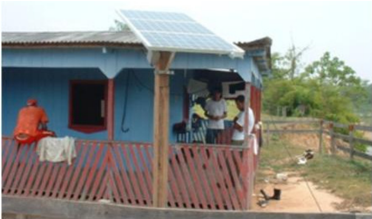
Figura 17. Sistema fotovoltaico isolado para abastecer uma residência em área rural sem acesso à energia elétrica.
