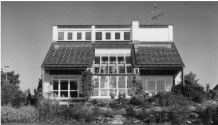
Figura 21. Instalação fotovoltaica típica na cobertura de uma residência participante do Programa 1.000 Telhados da Alemanha, com 5 kWp instalados (ERGE et al. ;2001).
