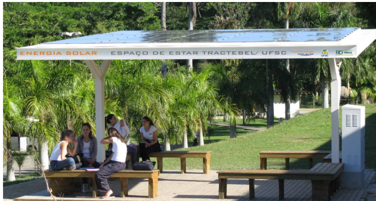
Figura 31. Sistema de 2 kWp integrado ao Espaço de Estar Tractebel/UFSC no Colégio de Aplicação.
