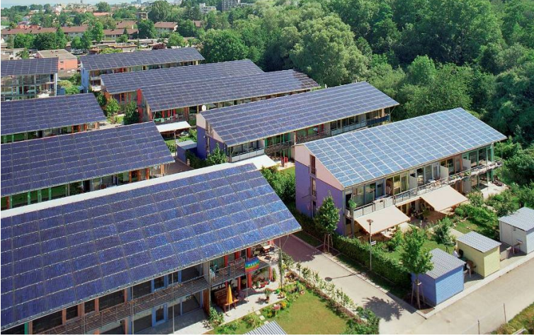
Figura 20. Telhados solarizados na cidade de Freiburg, na Alemanha.
