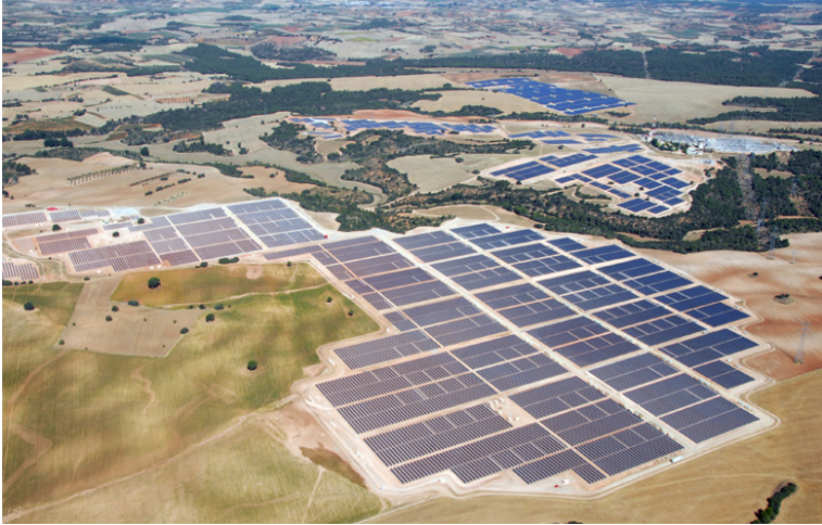
Figura 19. Parque fotovoltaico Olmedilla de Alarcón (Espanha), construído em 2008, com 60 MWp instalado (PVRESOURCES;2009).
