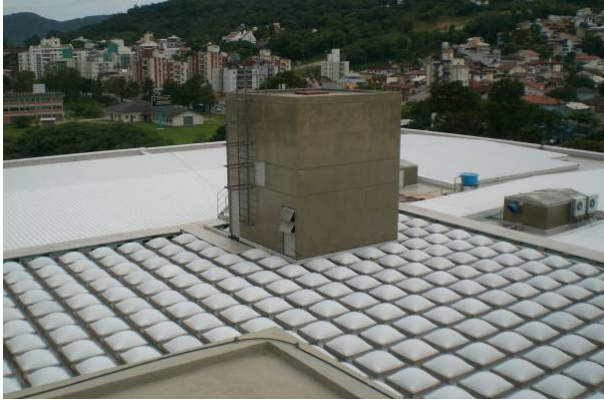
Figura 41. Detalhes da cobertura: telhas metálicas e domos para iluminação zenital.
