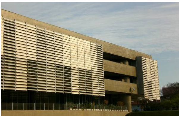
Figura 40. Edifício Sede da Eletrosul em Florianópolis – SC.
