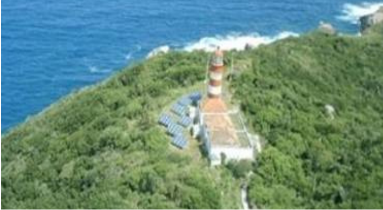
Figura 16. Sistema fotovoltaico isolado instalado na Ilha do Arvoredo.
