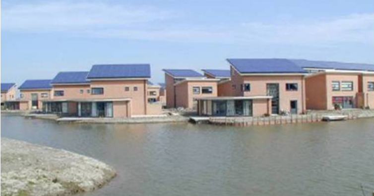
Figura 28. Vista da Mayersloot, Holanda com 130 kWp instalados (COBBEN et al. ;2008).
