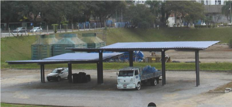
Figura 57. Coberturas existentes na parte posterior do edifício sede da Eletrosul.
