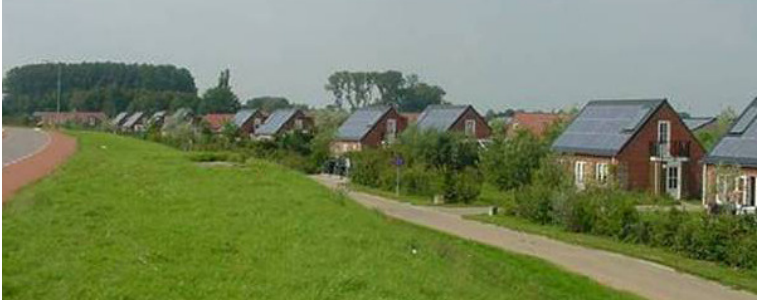
Figura 27. Holiday park Bronsbergen: 108 cabanas com telhados fotovoltaicos na Holanda (COBBEN et al. ;2008).
