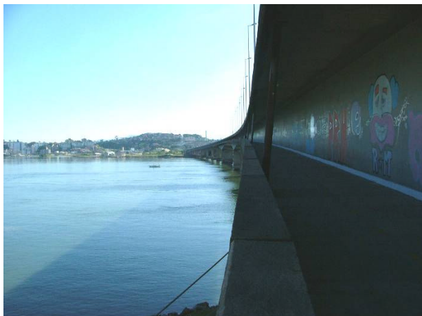
Figura 55 – Passarela no lado esquerdo da ponte Pedro Ivo. Fonte: da autora, 2004
