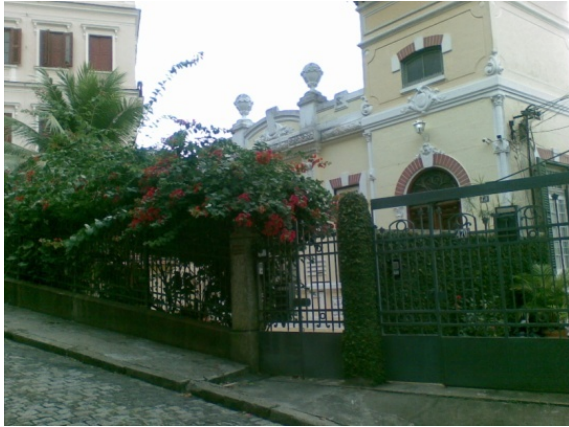
Figura. 17 – Casarão restaurado em Santa Teresa FONTE: Dc., 15 mai. 2009.
