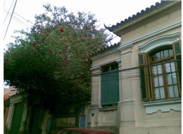
Figura 18 – Casarão restaurado em Santa Teresa FONTE: Dc., 15 mai. 2009.
