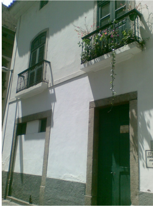
Figura 3 – Edificação colonial na Praça XV. FONTE: Dc., 22. fev. 2009.
