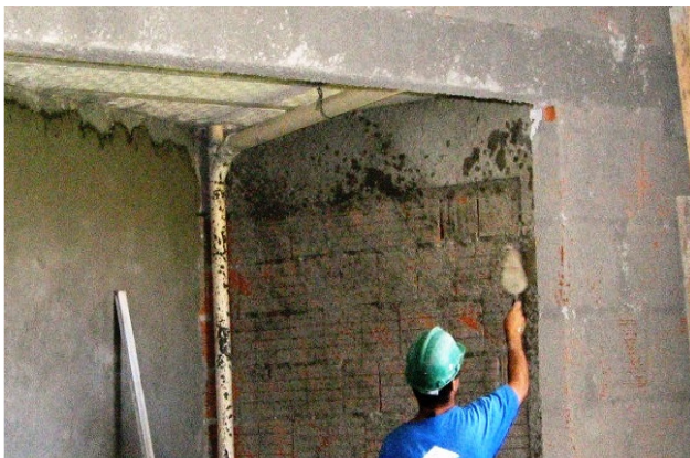
Figura 22 - Etapa de Revestimento Interno 01
