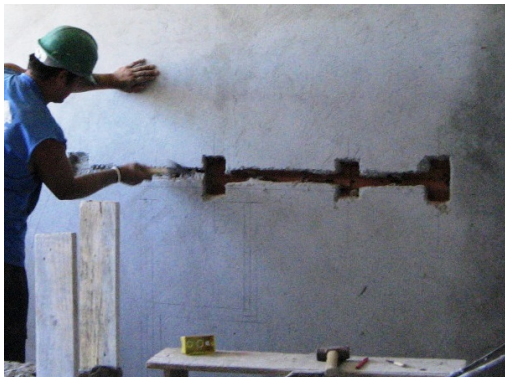
Figura 18 - Etapa de Instalações Elétricas 01
