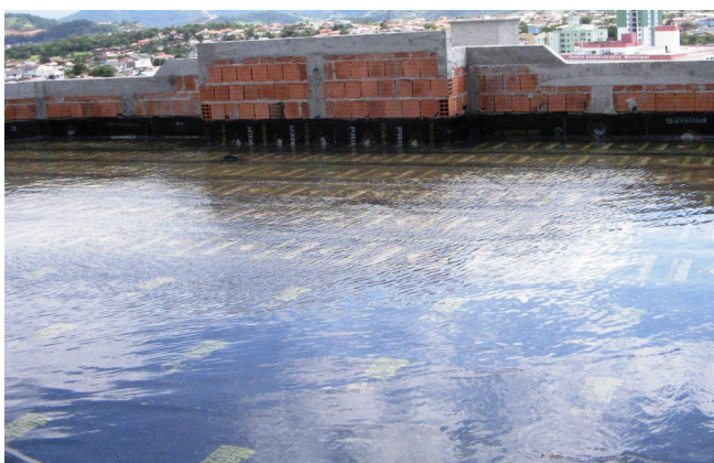
Figura 29 - Etapa de Impermeabilização com manta asfáltica
