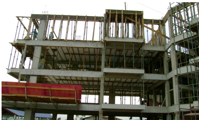
Figura 12 - Etapa de Supraestrutura 03
