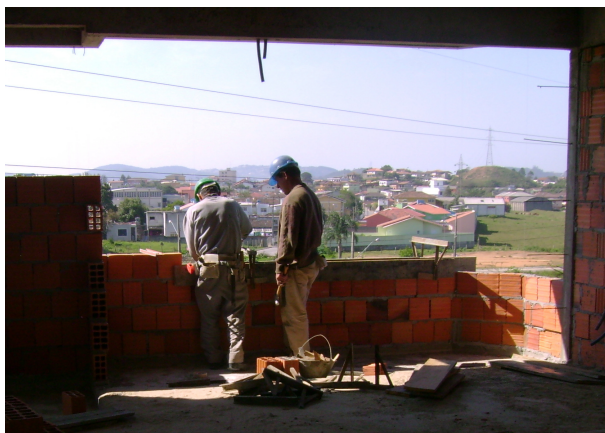
Figura 13 - Alvenaria visão interna.
