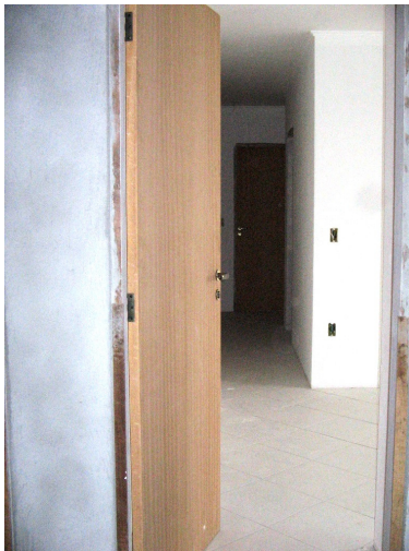
Figura 21 - Etapa de Instalações de Esquadrias de Madeira
