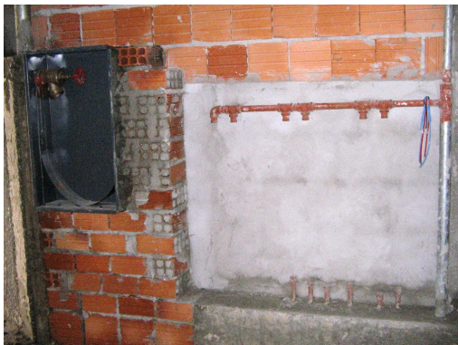
Figura 17 - Etapa de Instalações de Proteção e Combate a Incêndio e Instalações de Gás
