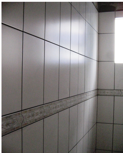
Figura 23 - Etapa de Revestimento Interno 02
