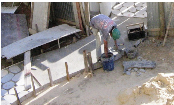
Figura 27 - Etapa de Pavimentação 02
