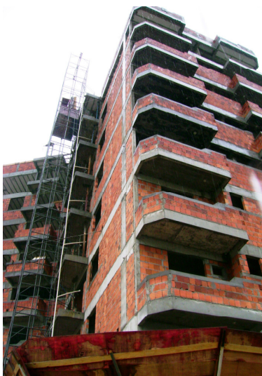
Figura 14 - Alvenaria visão externa
