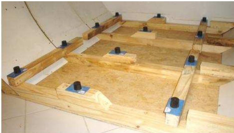
Figura 20: Montagem do sistema de isolamento para testes iniciais.
