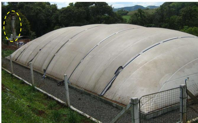
**Figura 17.** Biodigestor B8 e ao fundo o queimador.
