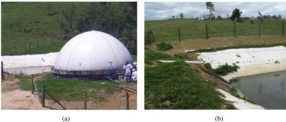
**Figura 11.** Biodigestor B1: (a) biodigestor; (b) lagoa de armazenamento do efluente.
