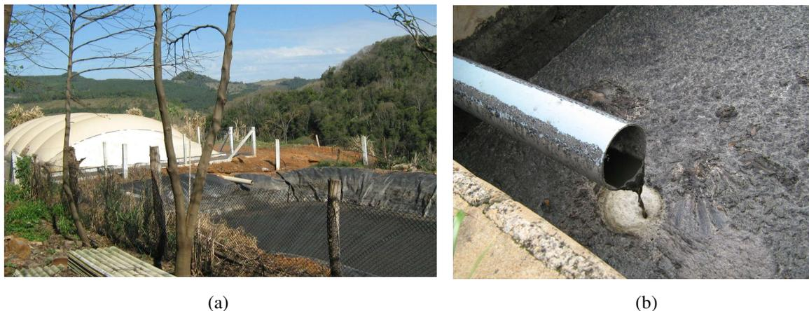
**Figura 15.** (a) Biodigestor B11 seguido da lagoa; (b) detalhe da tubulação de efluente na lagoa do B10.
