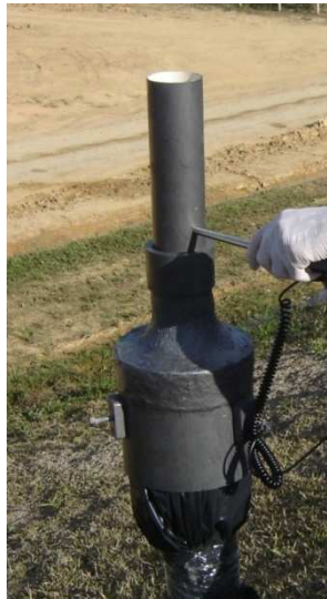
Figura 16. Bocal instalado no dreno.
