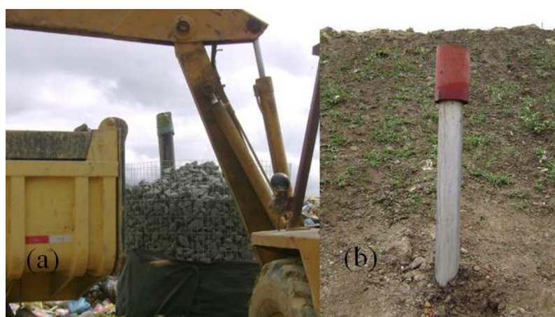
Figura 10. Dreno de biogás.
