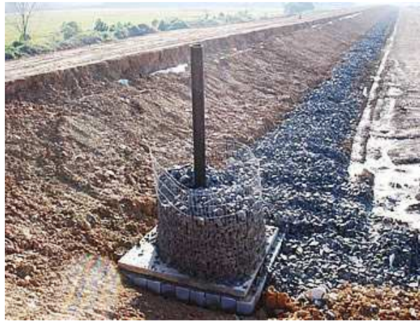
Figura 3. Sistema de drenagem de gases.
