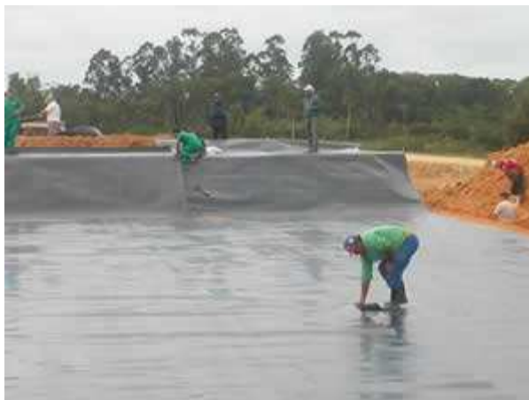
Figura 2. Colocação da manta PEAD
