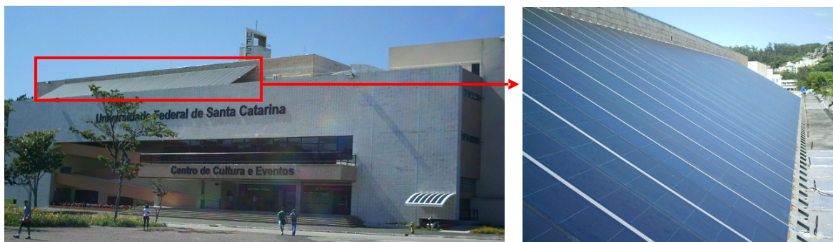
Figura 11 – Instalação de 10kWp no prédio do Centro de Eventos da UFSC
