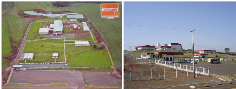
Figura 9 Vista das instalações do Frigorífico Anhambi Fonte: Frigorífico Anhambi, 2008.
