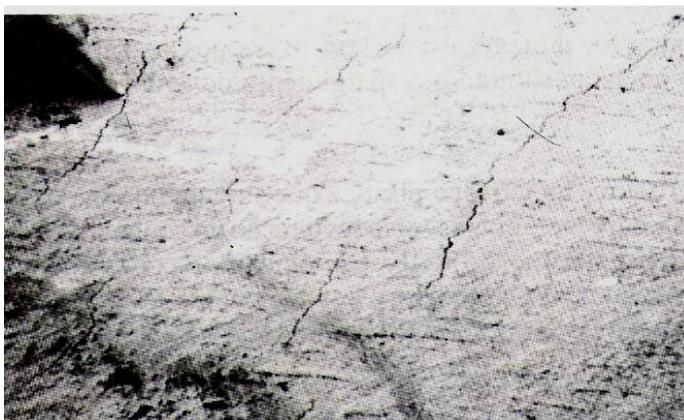
Figura 6 - Fissuras por retração plástica no concreto fresco (Mehta e Monteiro, 1994).
