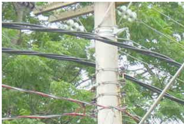
Figura 4.3 – Estrutura com três alimentadores, onde dois são em rede multiplexada
