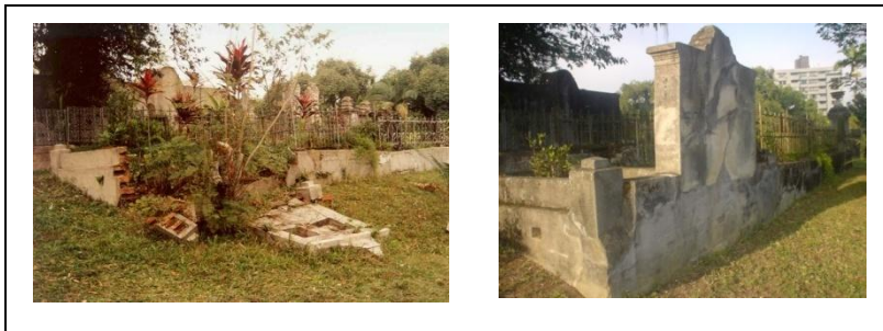
Figura n. 28 – Túmulo em alvenaria de tijolos, antes e depois da restauração, em 2000. Consolidação realizada com argamassa mista. (T380, fotos acervo do CPBC)
