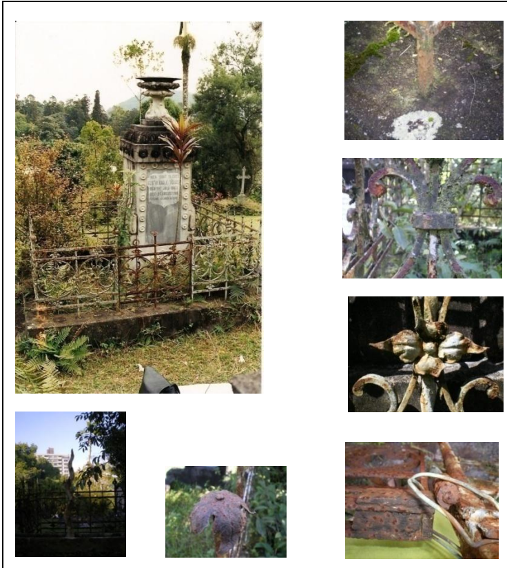
Figura n. 37 – Vista frontal do túmulo T384 e detalhes, em sentido horário: do gradil chumbado na base de alvenaria; volutas unidas por anel; volutas unidas por solda, seguido da aplicação de um elemento floral; elementos do portão unidos por solda; elemento floral de uma das quatro extremidades fixado com rebite e; ponta de lança terminada em flama. (Imagem do túmulo do Acervo do CPBC - T384-1999-0001-18 e fotografia dos detalhes de CARRASCO, 2009)
