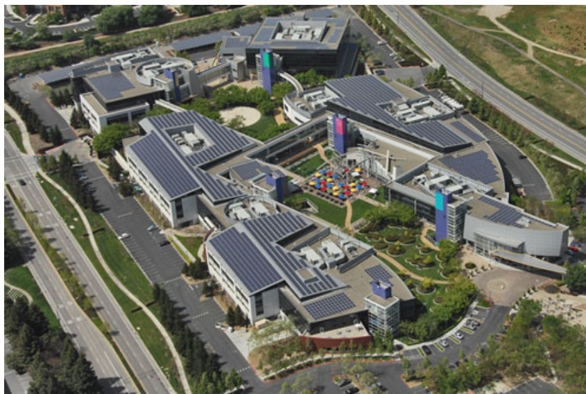
Fig. 1.1 – Painéis solares ocupam praticamente todos os espaços disponíveis nos telhados dos prédios do complexo da Google.
