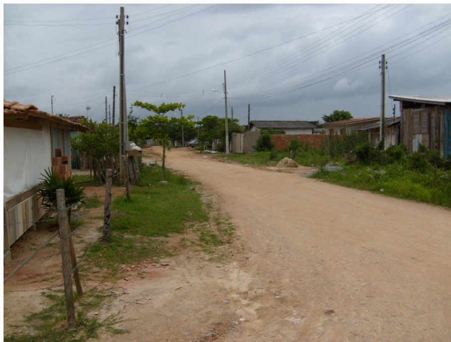
Figura 28: Falta de Infra-estrutura no bairro de Laranjeiras.
