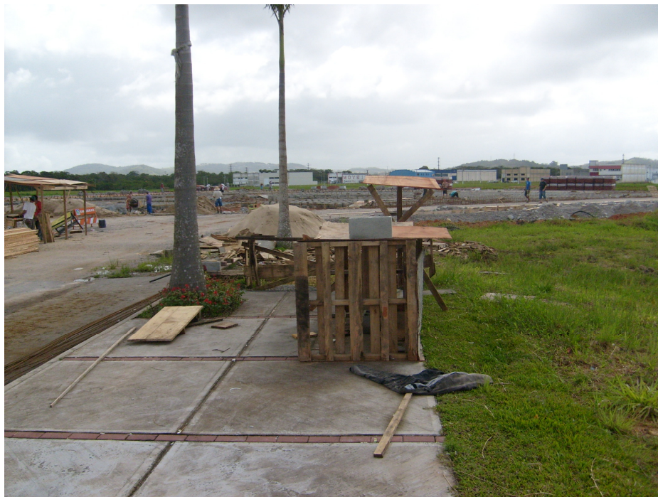
Figura 42: Obras iniciais do setor central
