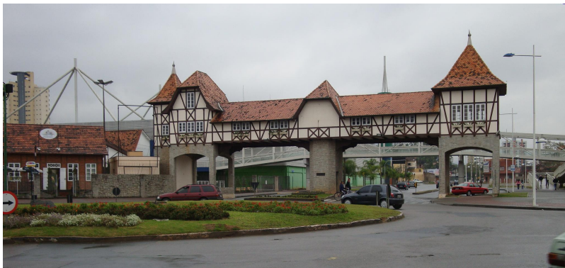
Figura 24 - Vista do pórtico da Rua Humberto de Campos, junto ao Parque Vila Germânica
