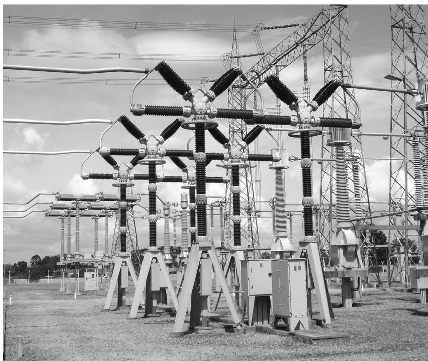
**Figura 6.15:** Fotografia de disjuntores Merlin Gerin FA4 (550kV)
