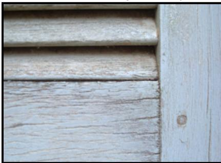
Figura 13 – Fissuras superficiais, tratamento com remoção parcial.
