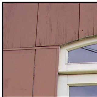
Figura 85 – Marca da intervenção de substituição. Fonte: Autora, 2008
