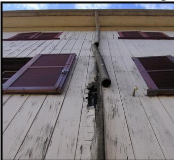
Figura 69 - Falta de manutenção na tubulação. Fonte: Autora, 2008
