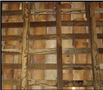
Figura 11 - Túneis construídos por cupins subterrâneos. Fonte: Autora, 2008
