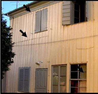
Figura 46 - Substituições parciais das tábuas de vedação. Fonte: Autora, 2008
