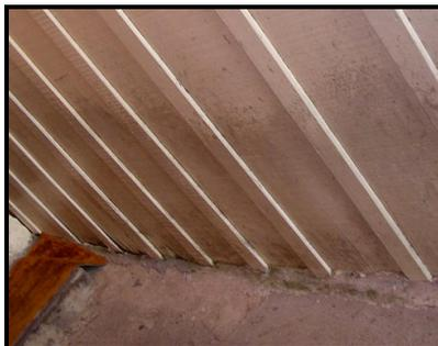
Figura 45 - Provável ataque de fungos na vedação próxima ao piso. Fonte: Autora, 2008
