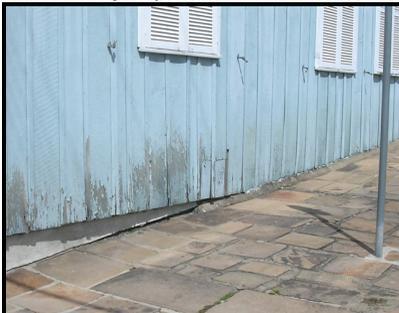
Figura 59 - Calçada cobrindo parte da parede. Fonte: Autora, 2008
