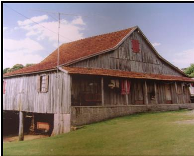
Figura 40 - Residência construída com madeira falquejada. Fonte: Roveda, 2007
