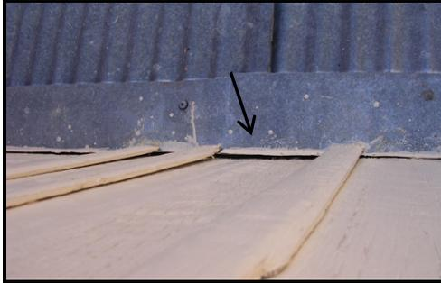
Figura 73 - Frestas entre o telhado e a parede. Fonte: Autora, 2008
