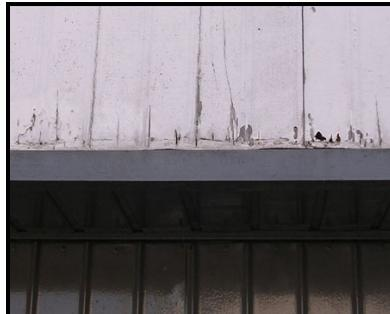
Figura 75 - Ponto de acúmulo de água, entre a parede e o marco da esquadria.
