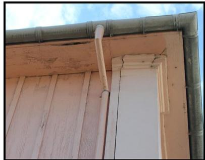
Figura 72 - Infiltração no beiral.
