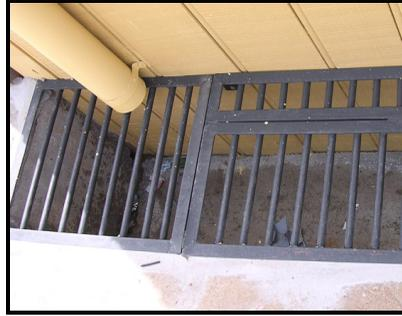
Figura 63 - Detalhe inadequado da madeira dentro da canaleta. Fonte: Autora, 2008
