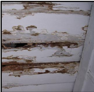
Figura 71 - Degradação do forro.
