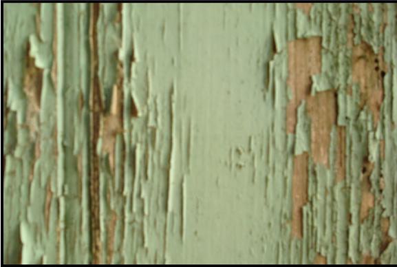
Figura 14 - Tinta extremamente degradada, tratamento com remoção total.
